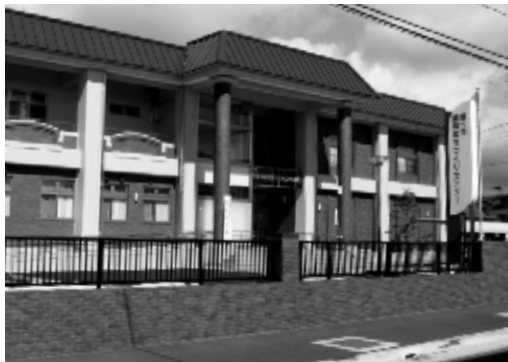
平成22年に移転改築した鷹岡まちな くりセンター
