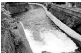
天間地区用排水路整備状況
