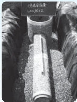
○雨水浸透ます A型 浸透ます 浸透トレンチ管
