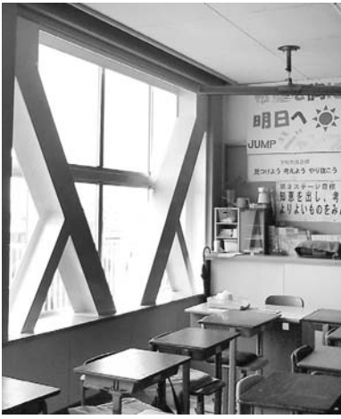
耐震補強工事が完了した教室。窓の位置に設置された強固な鉄骨の補強材が、子どもたちを地震から守ります。
