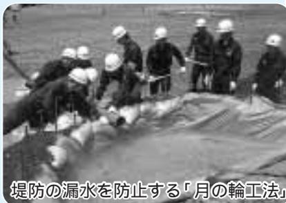
堤防の漏水を防止する「月の輪工法」
