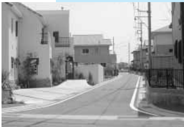
拡幅された広い道路
