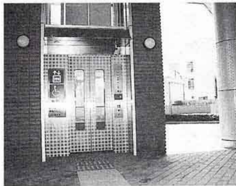
▲富士駅南口エレベーター
