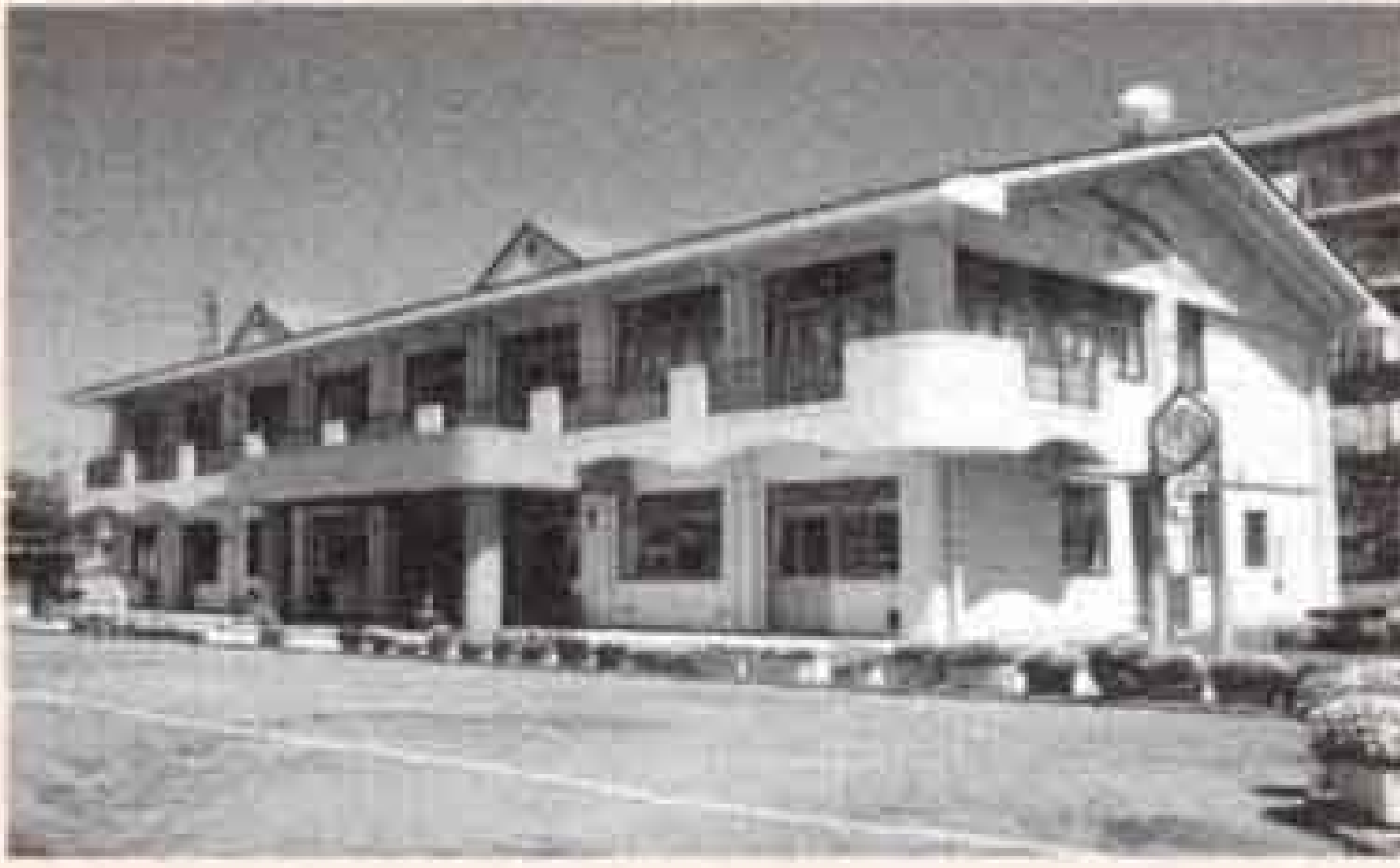
▲平成11年4月に落成した 天間幼稚園園舎
