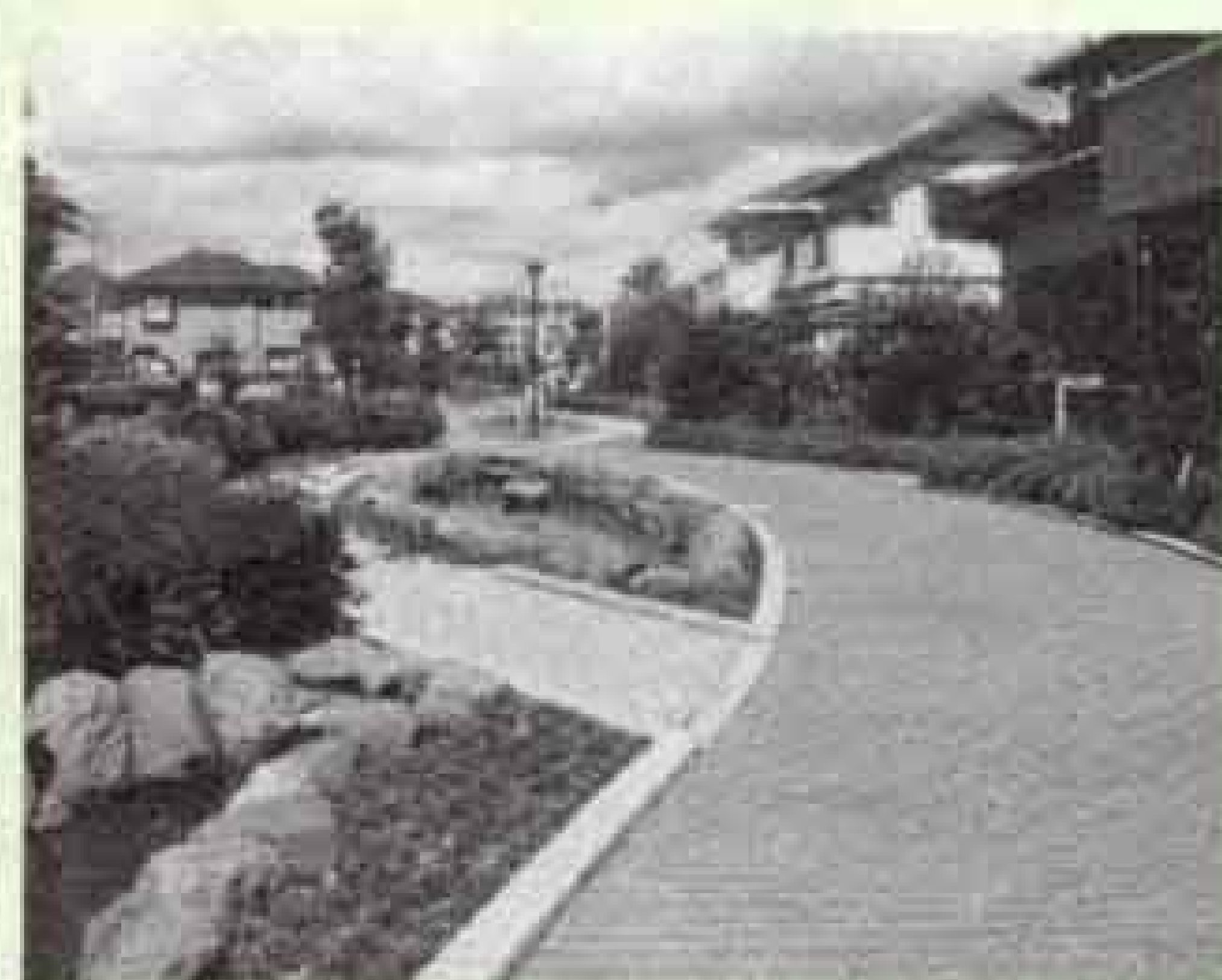
▲富士中部土地地区画整理事業では、中央歩行者道を整備するなど、生活環境に配慮した潤いのあるまちづくりを進めました。
