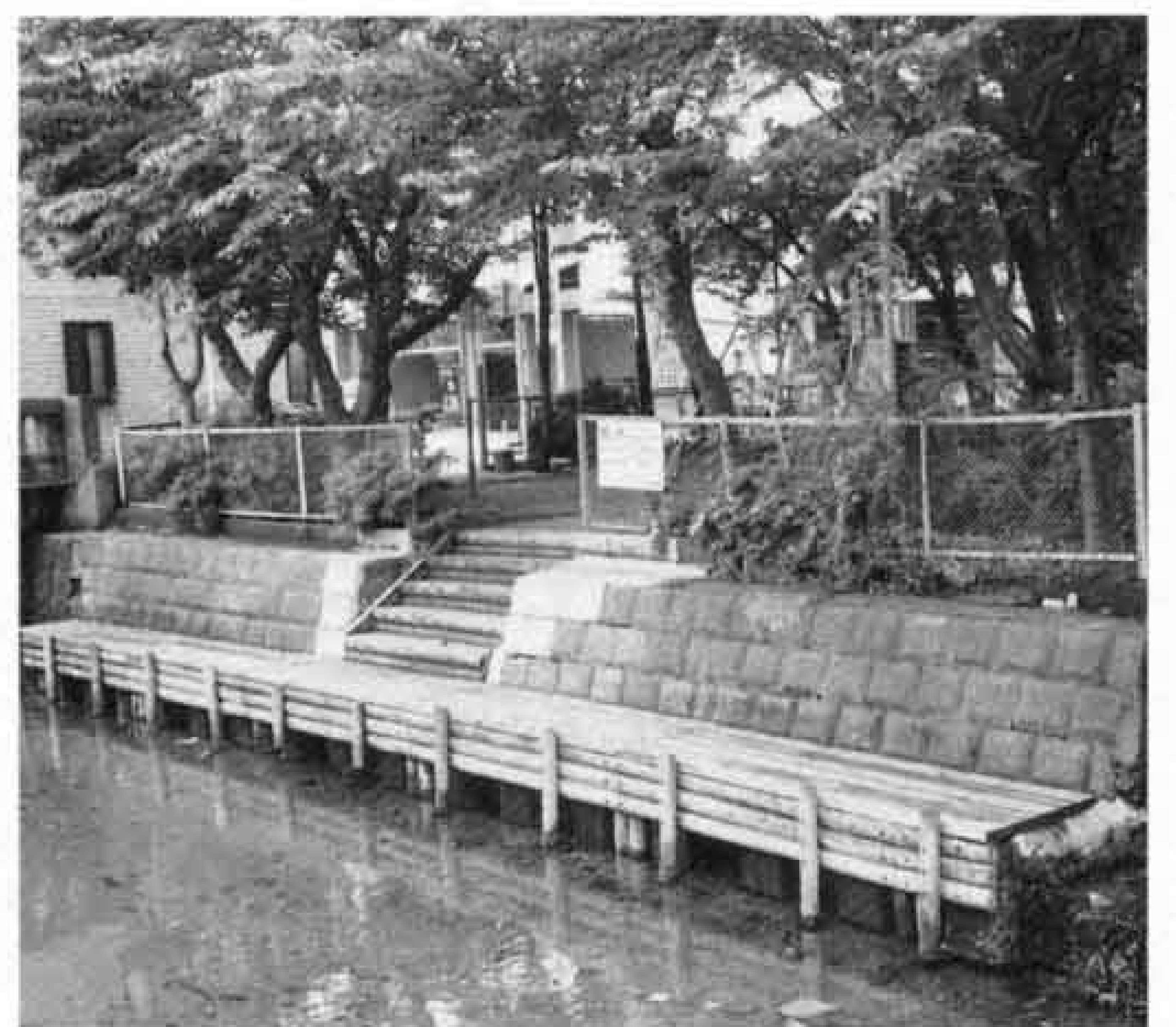
栄町公園から川に降りられるよう、矢板で足場が整備され、水に親しめる空間として、子供たちの格好の遊び場となっています。
