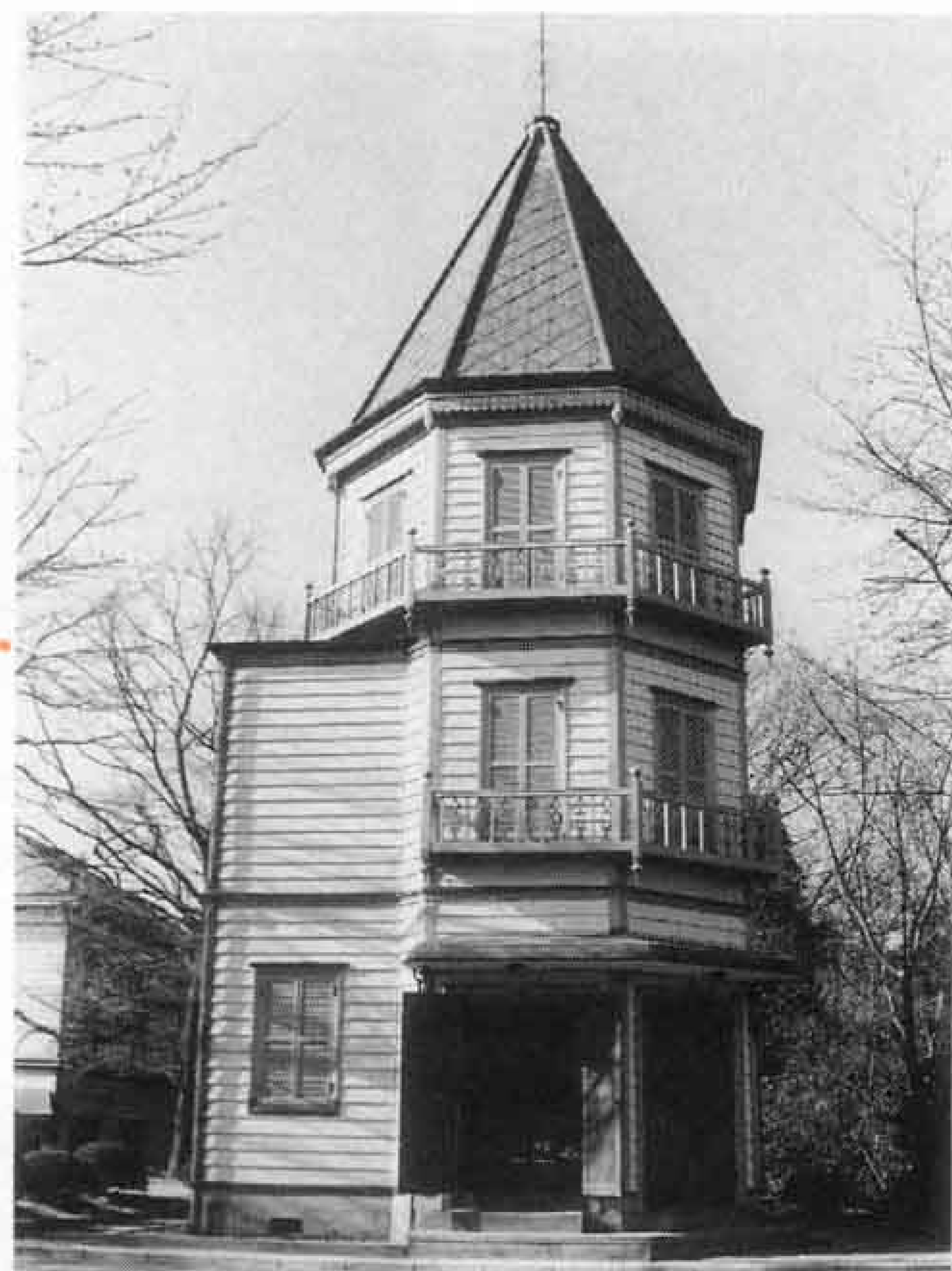
ちょうほうかん ▲眺峰館 3階建て正八角形、避雷針付きのトタン屋根。ハイカラな建物でひととき目立ちます。料理店の玄関部分だったものを移築したものです。
