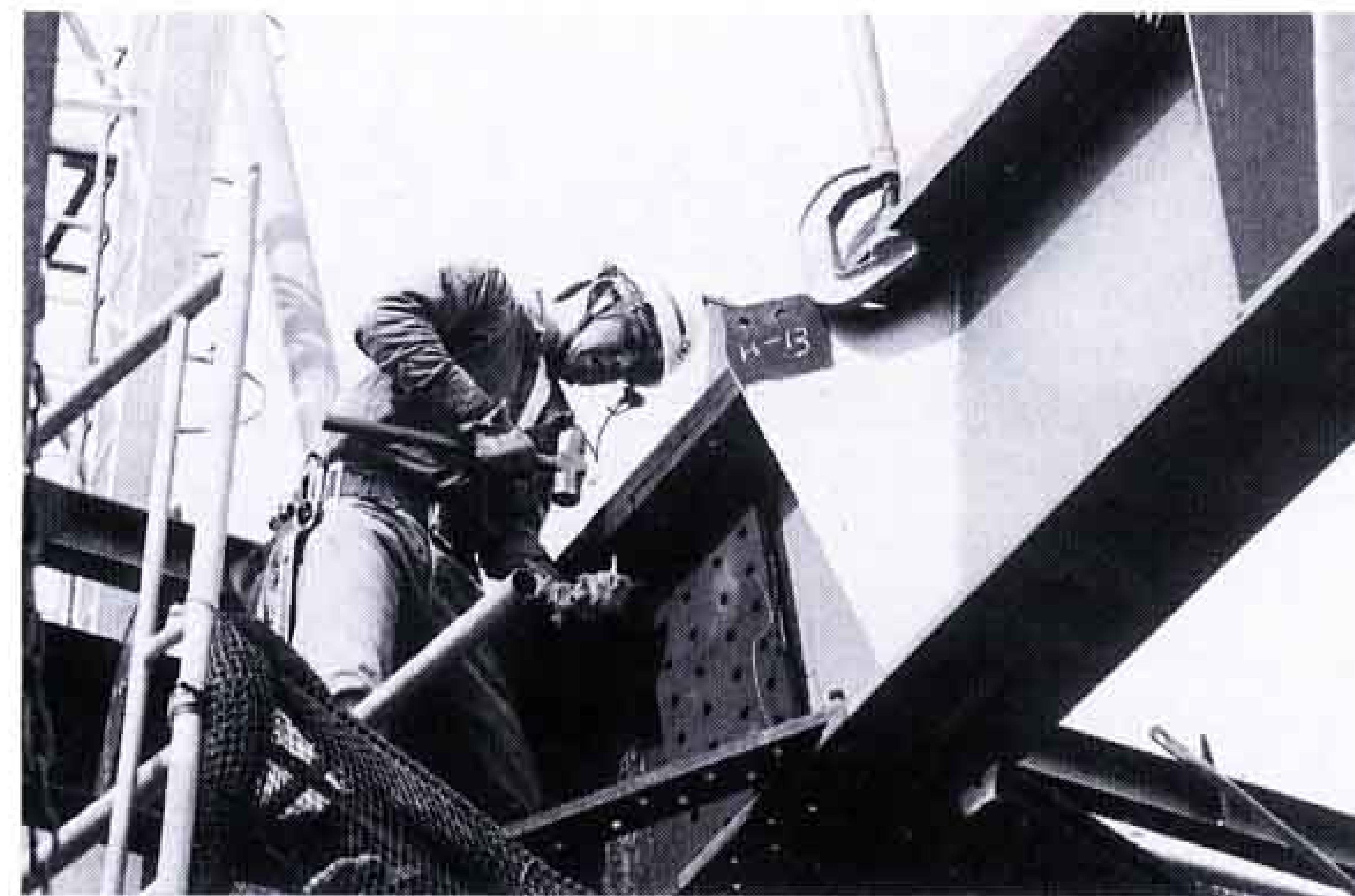
△ **とび職** ここは高さ30㍍の鉄骨の上。ロゼシアターの“骨”となる鉄骨を組み上げるのはとび職の仕事です。足がすくんでしまうような、高くて細い鉄骨の上を、1日中飛び回っています。
