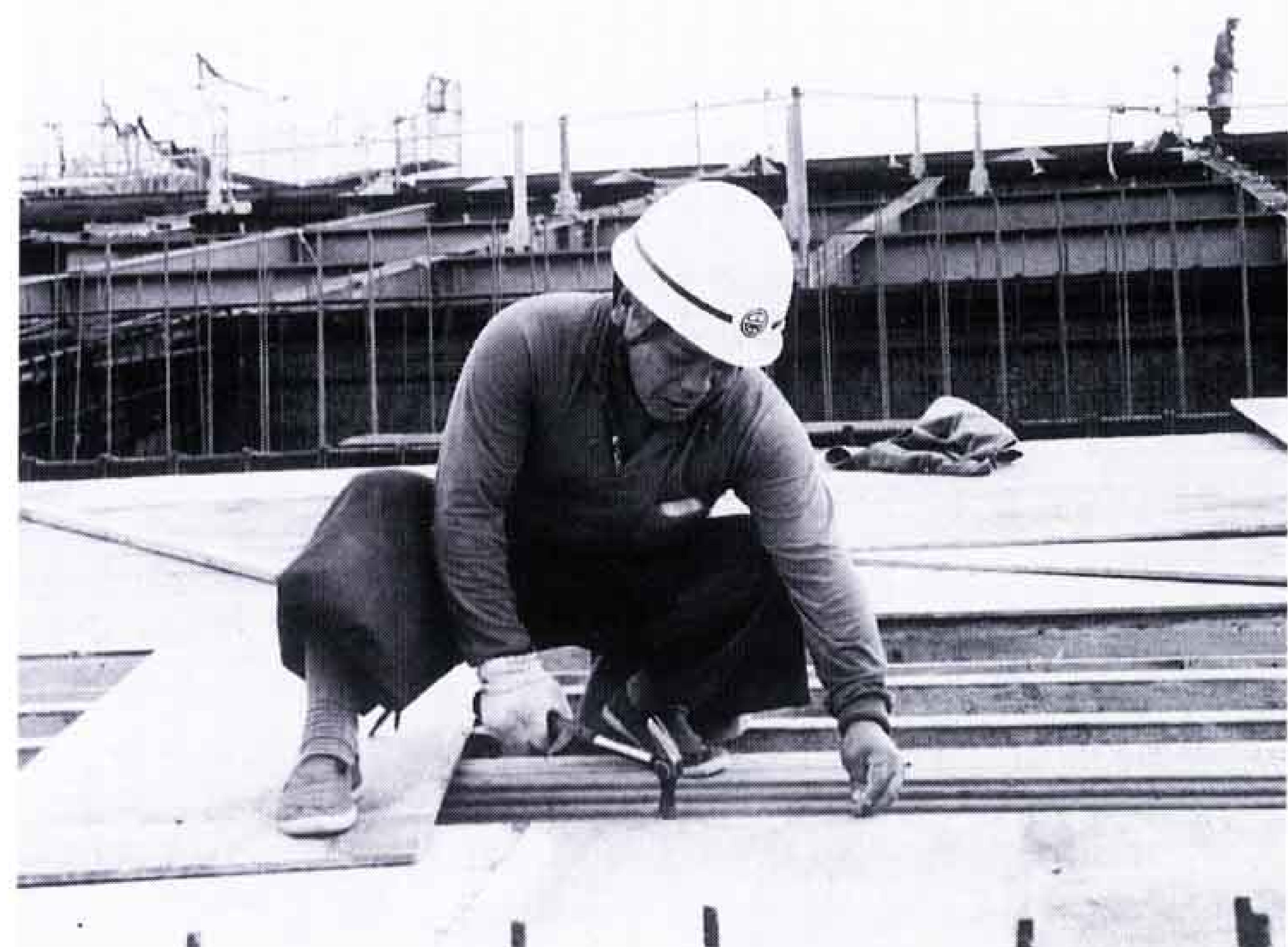
△ **型枠大工** コンクリートを流し込む木の枠をつくるのが、型枠大工。この型枠が曲がったりゆがんだりしていると、コンクリートもゆがんでしまうので、とても気をつかいます。
