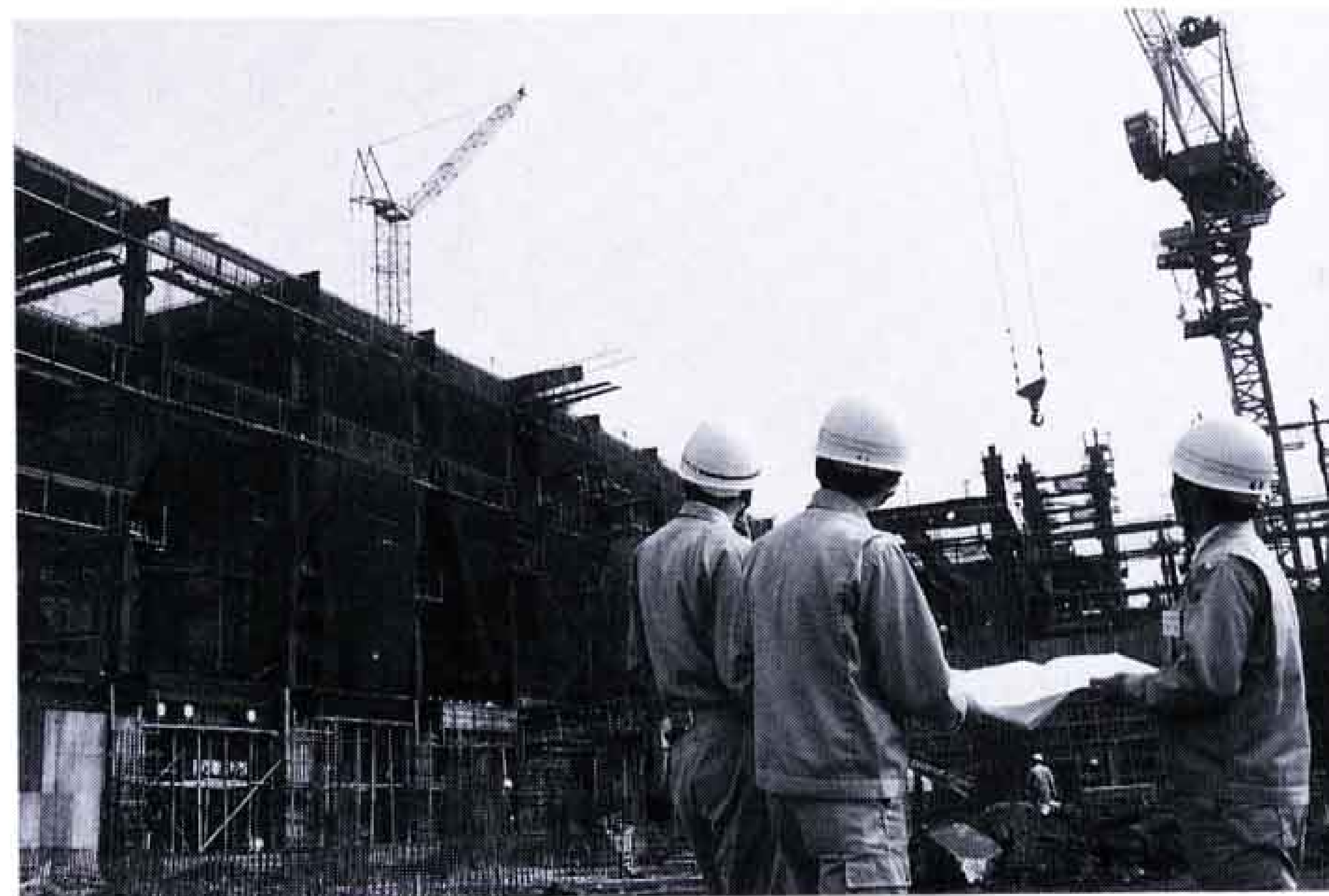
文化会館の建設現場
