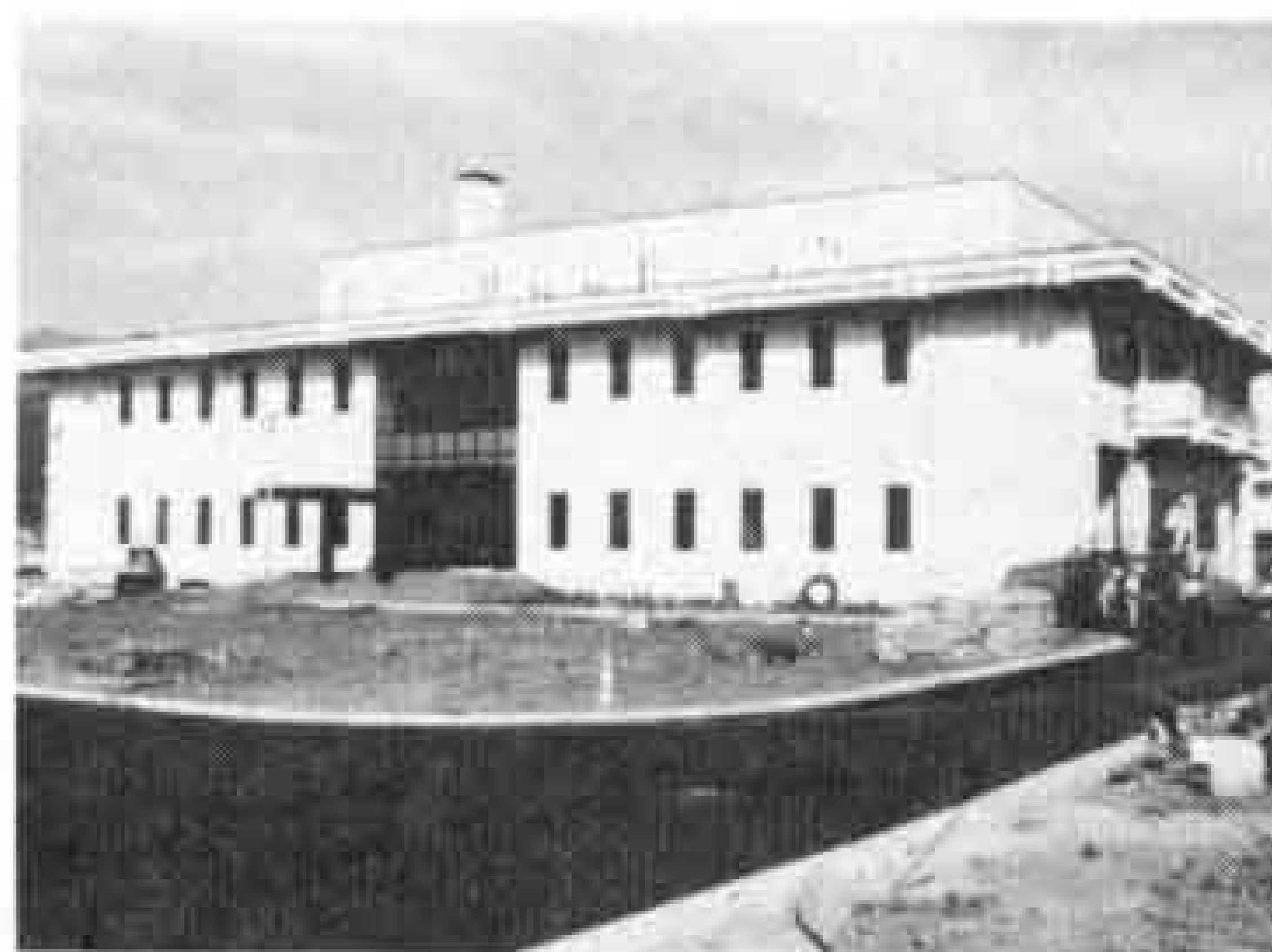
△4月1日から通水を開始した東部の下水道浄化施設
