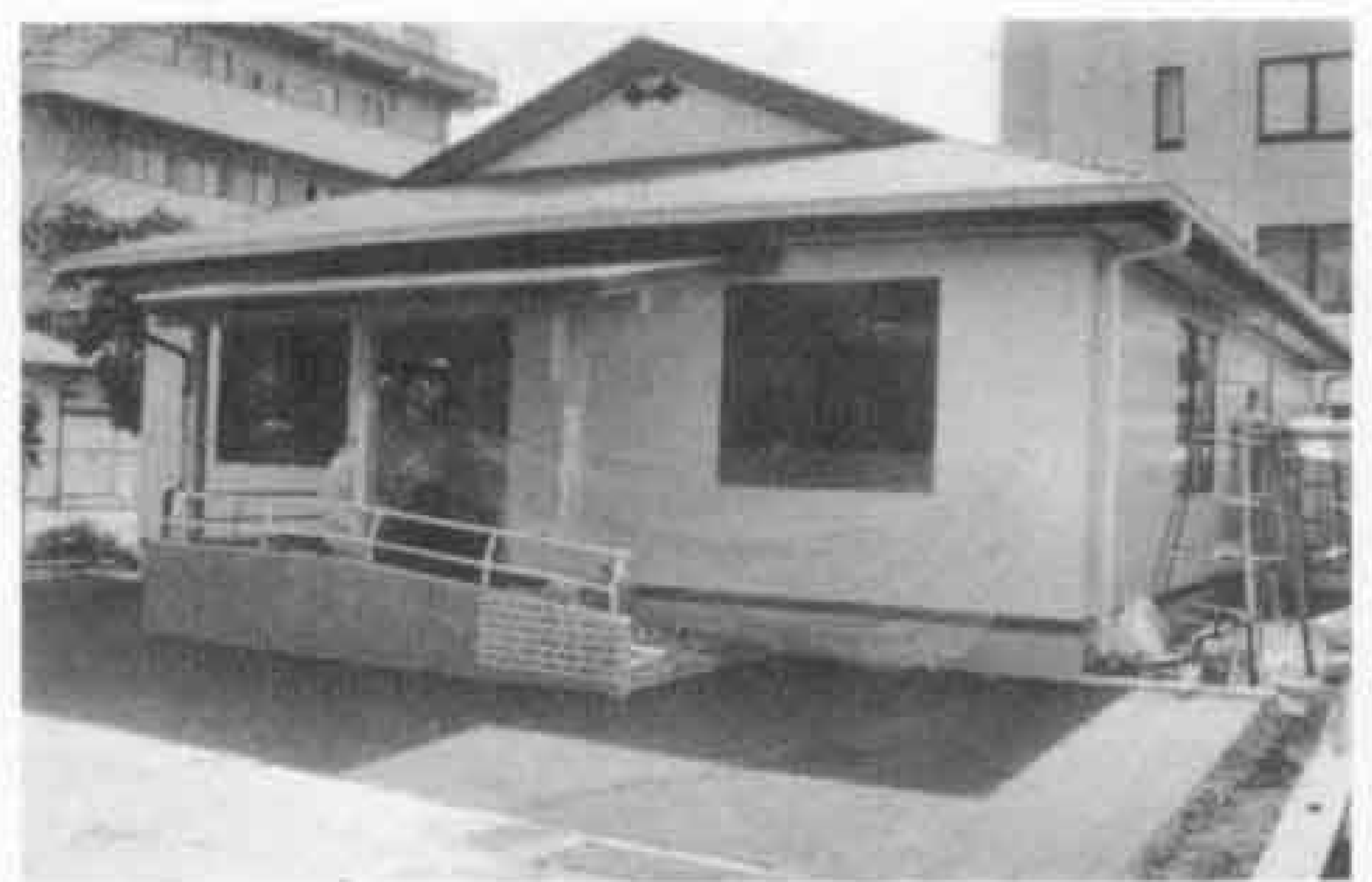
中央町に建設中の高齢者介護ホーム
