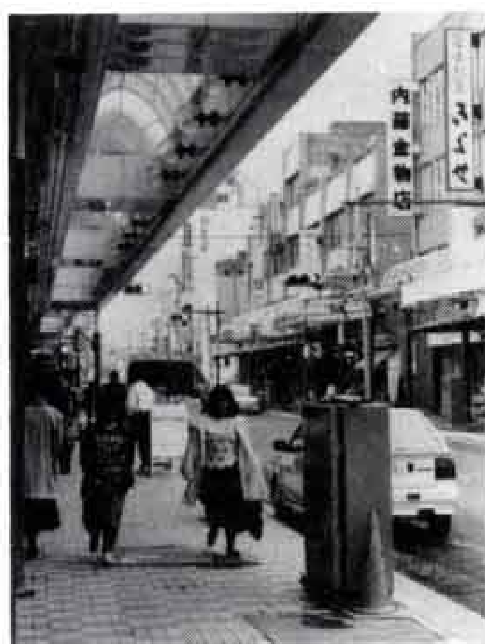
吉原商店街の電線地中化工事
