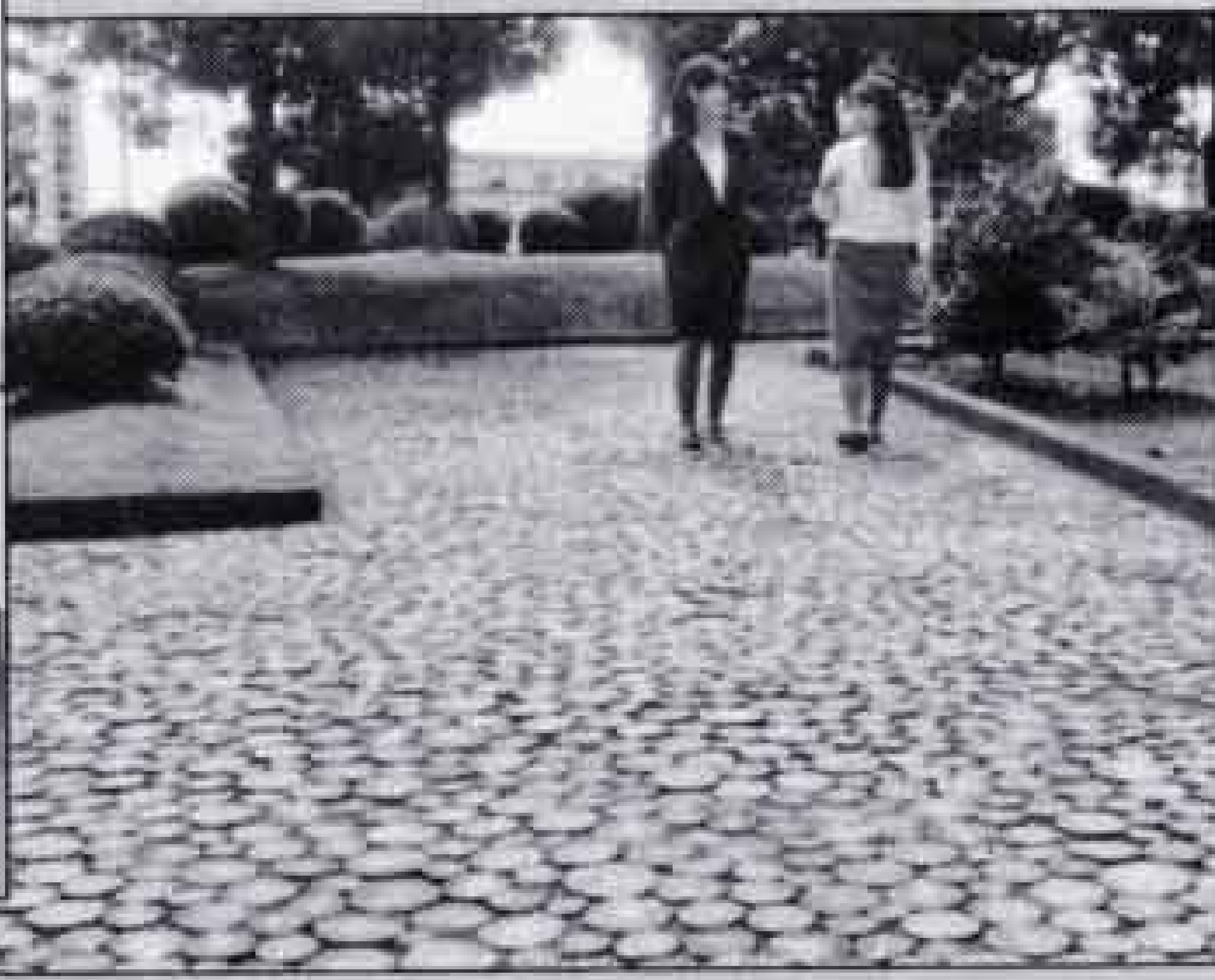
▽間伐材を敷き詰めた歩道(市役所公園広場)
