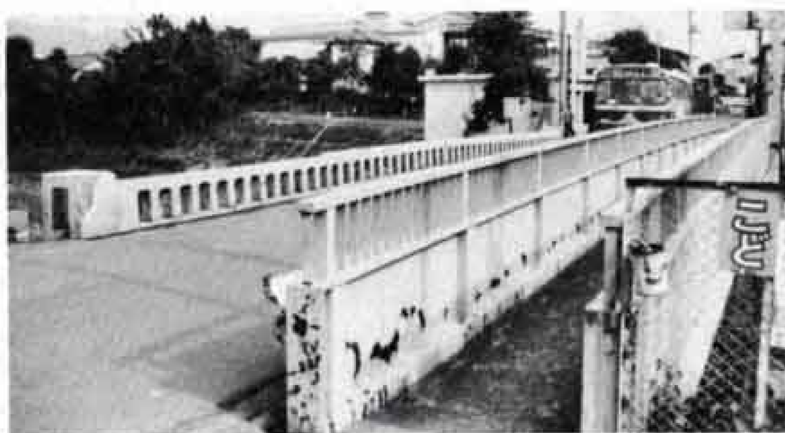
昭和61年10月のすその橋。歩道もついています。
