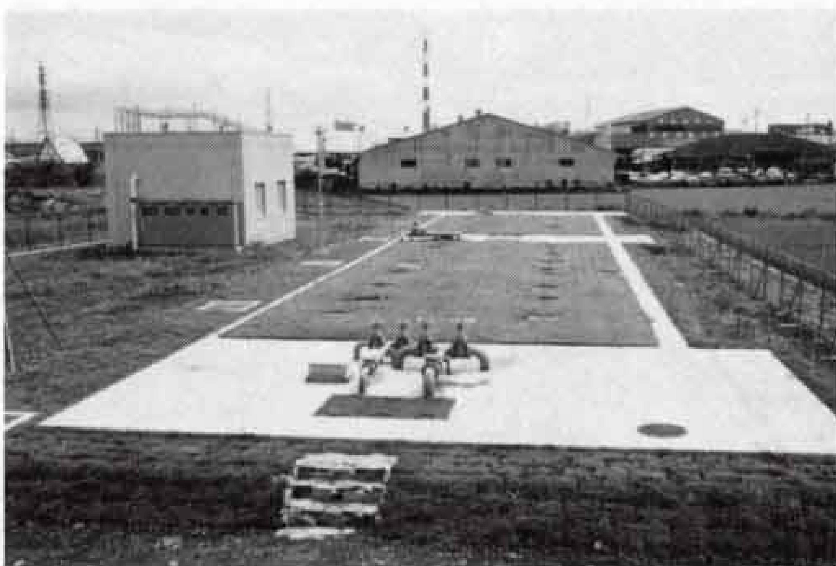
△全国で初めての処理方式「礫間接触酸化法」を採用した吉原下水処理場
