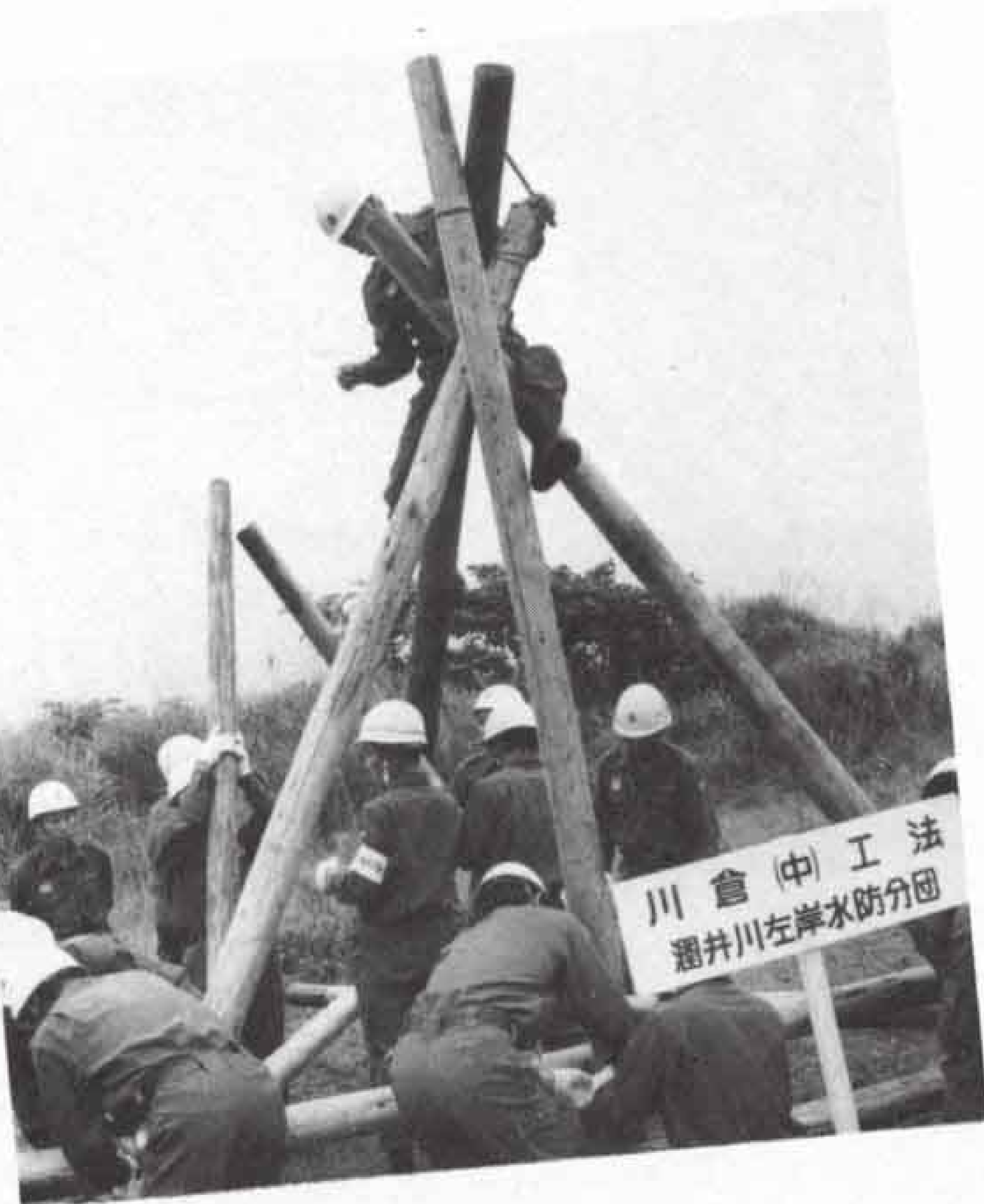
▷スピーディーに仕上がりました(川倉工法)
