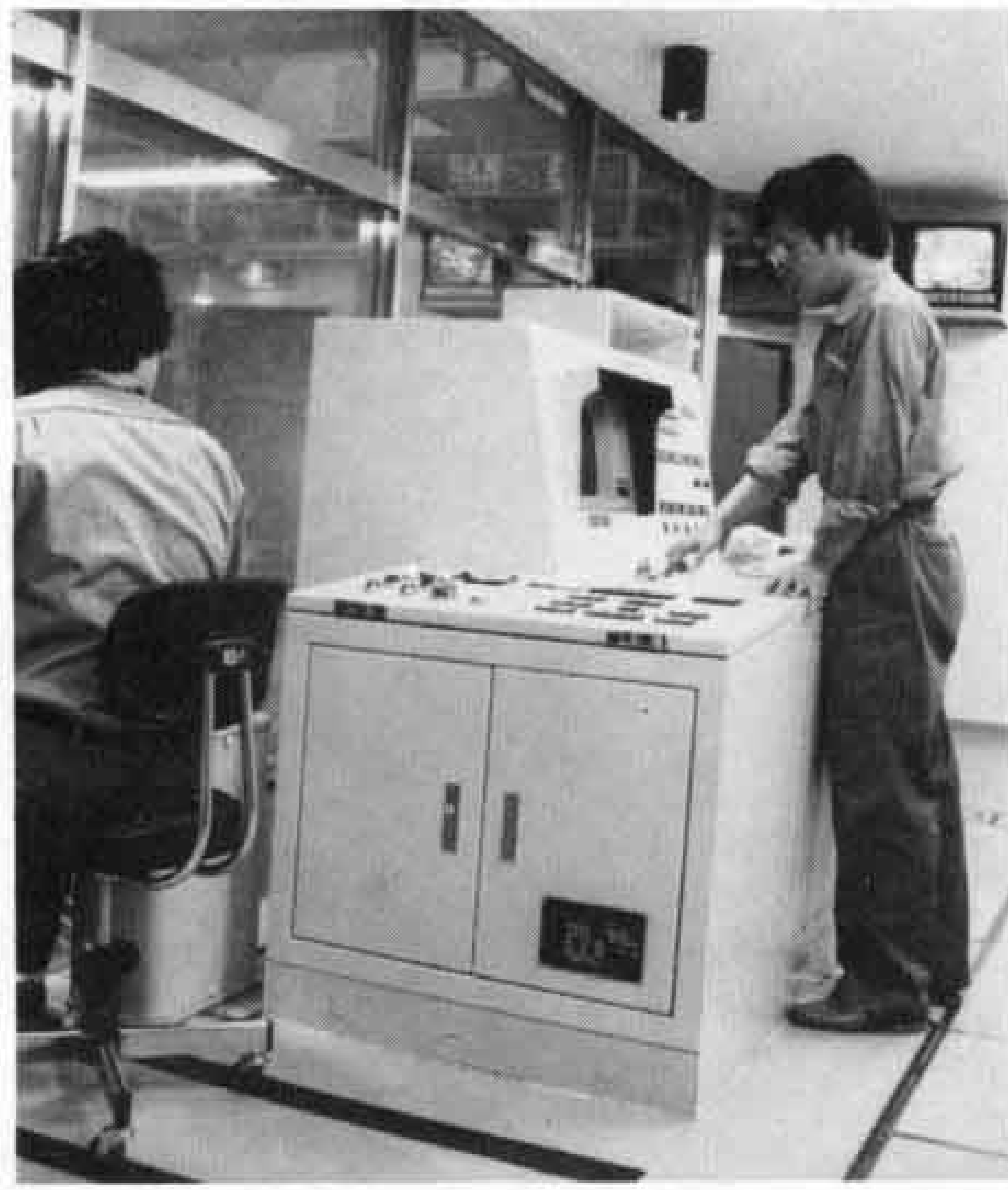
▷クレーン操作室(ごみを焼却炉へ運びます)
