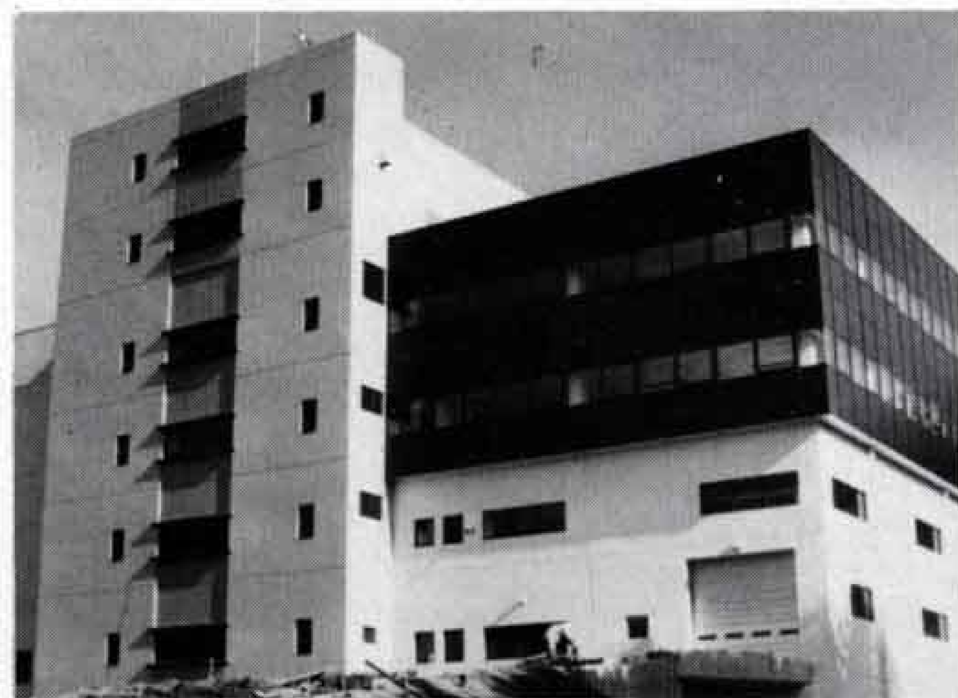
第一清掃工場
