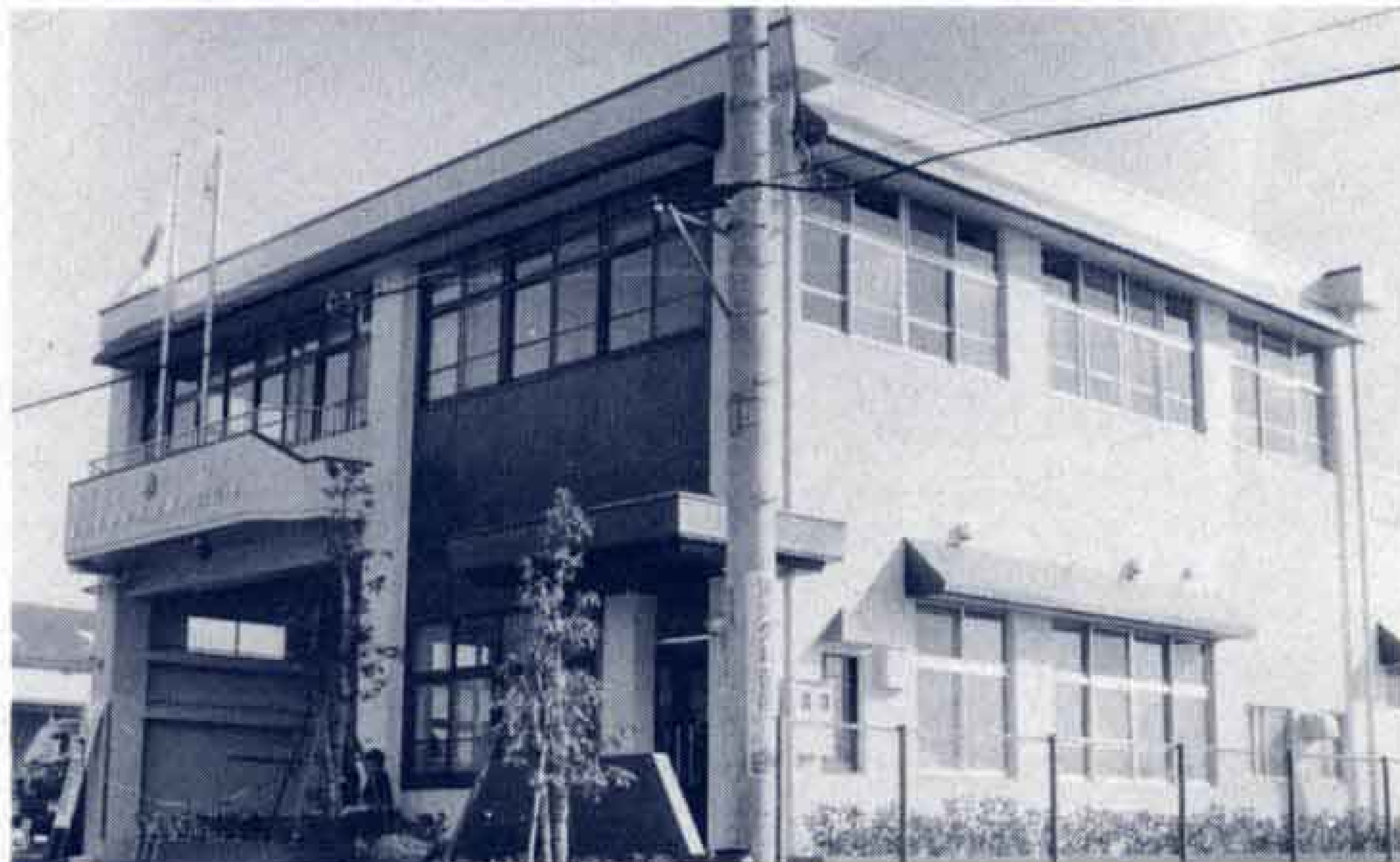
▲市内中野に完成した中央消防署大淵分署
