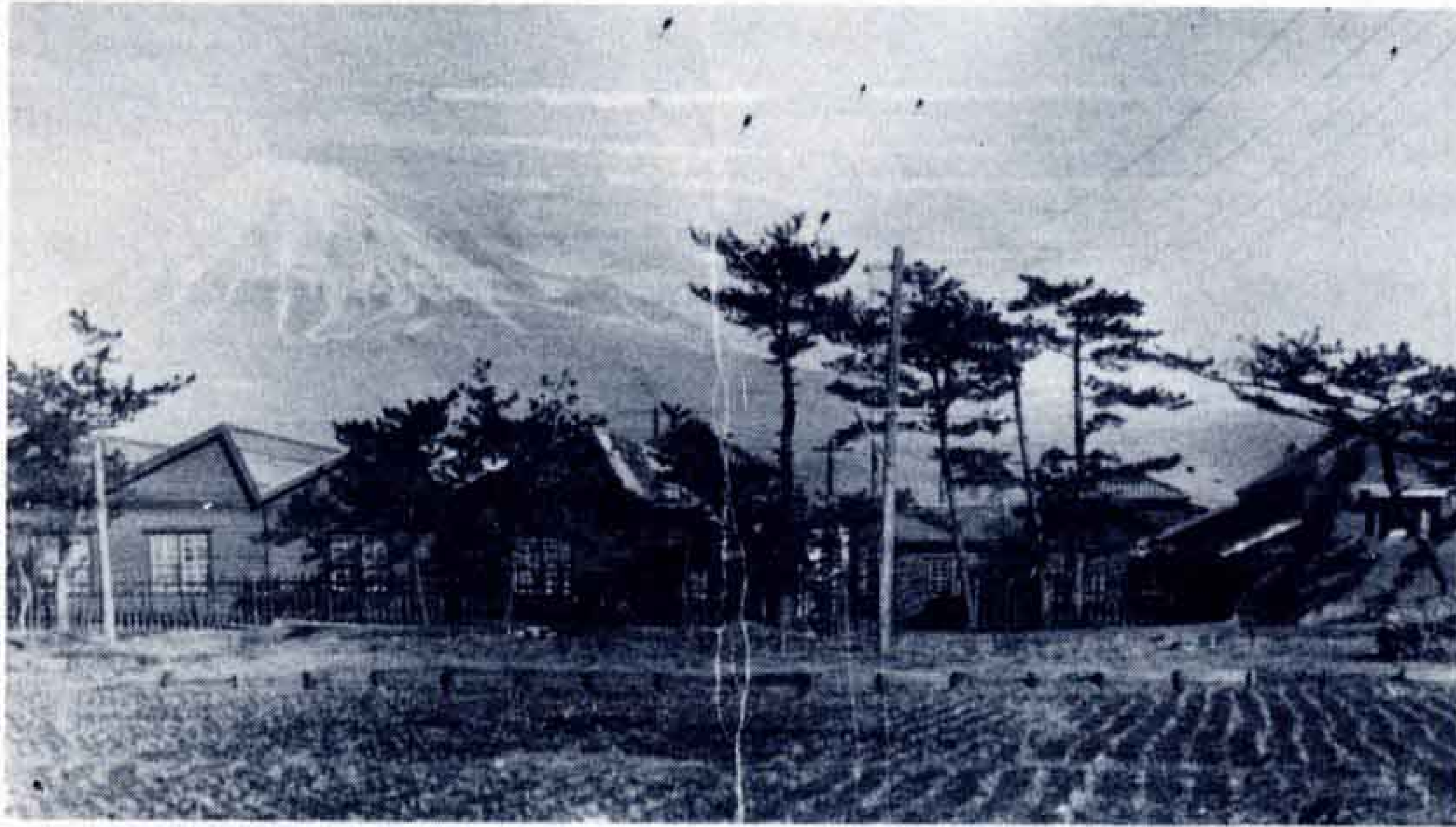
東京艶糸株式会社工場全景（富士明治会提供）
