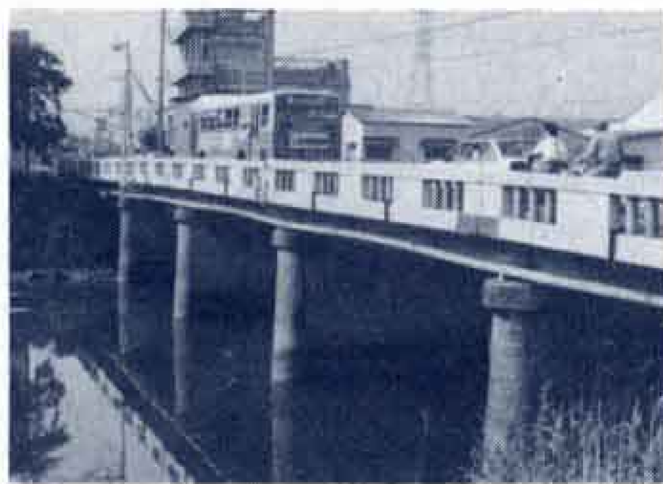
📷 コンクリート製になった河合橋
