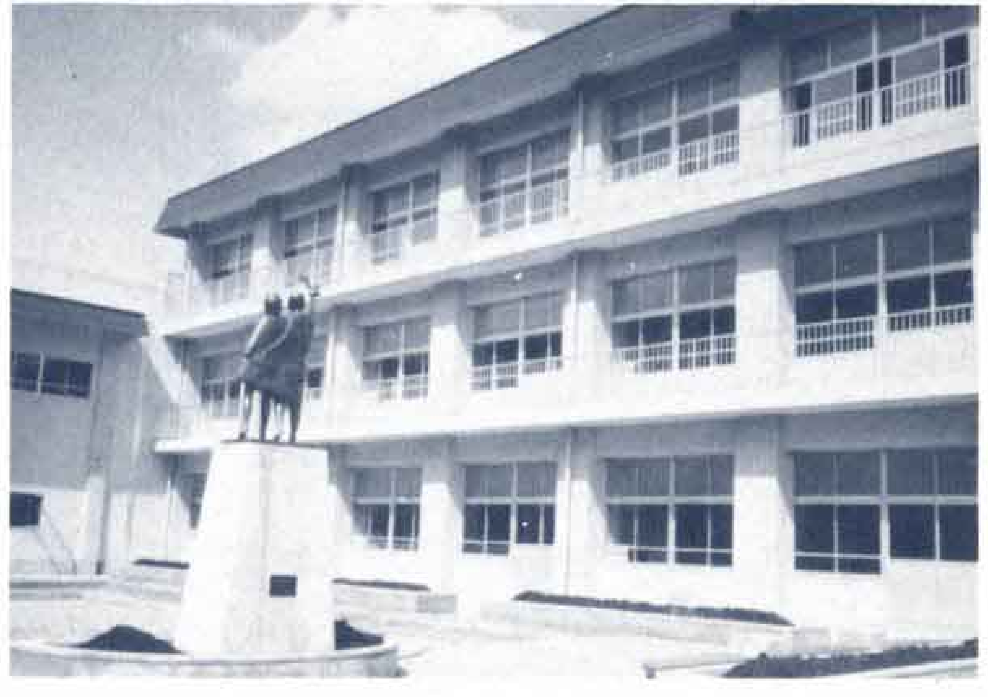
吉原北中学校 鉄筋コンクリート3階建て
