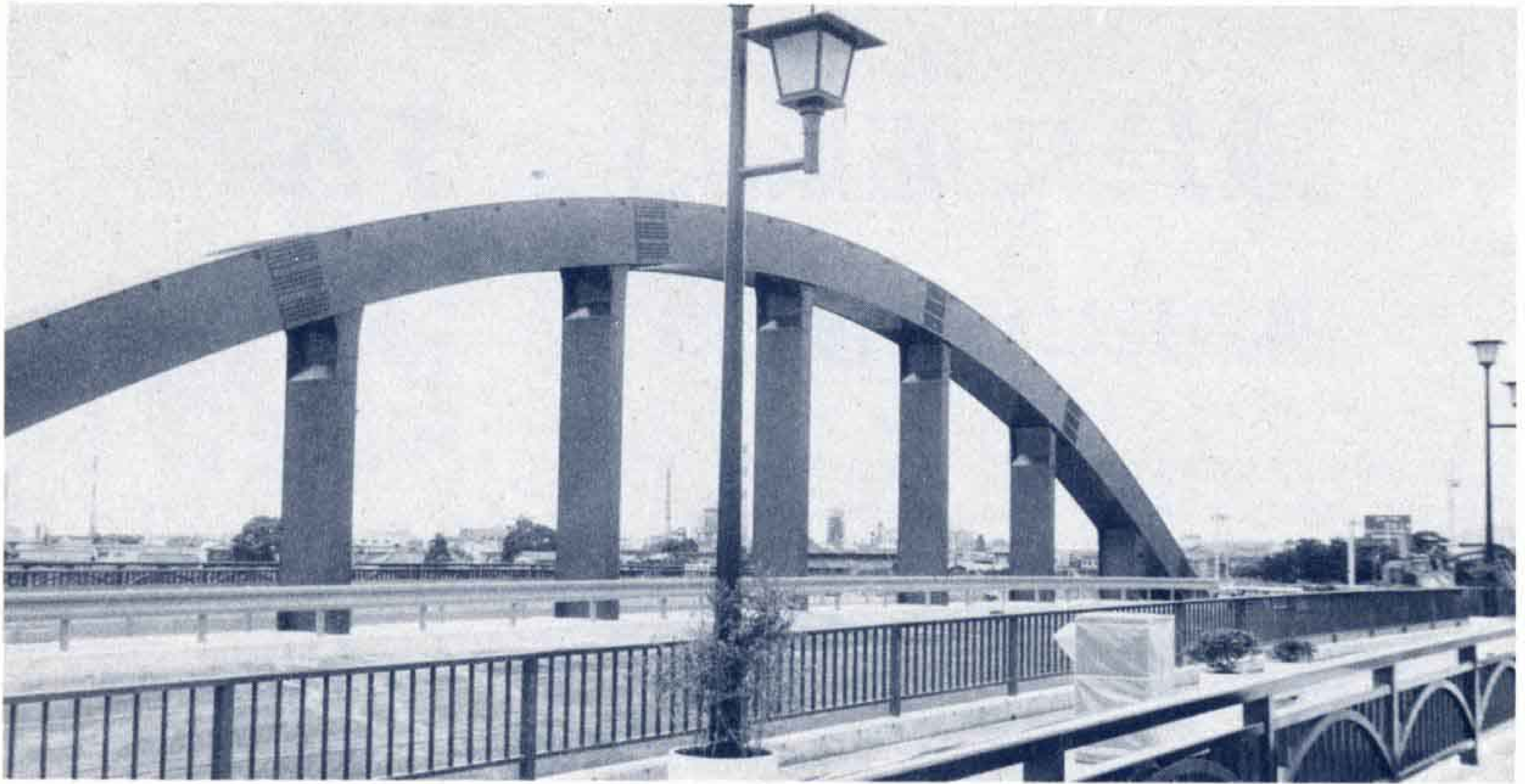
△市のシンボル橋、潤井川大橋
