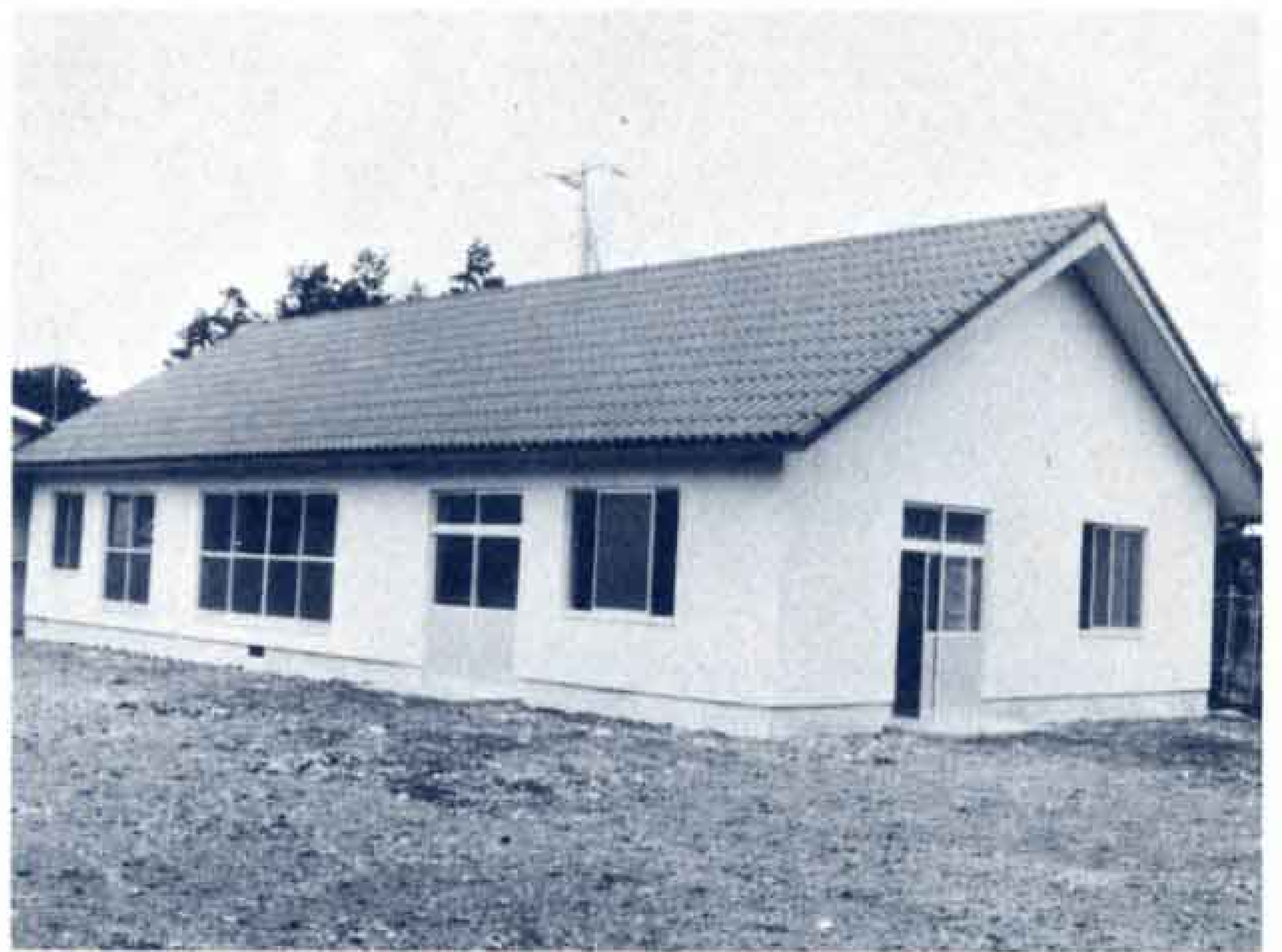
▲4月15日完成した新作業棟
