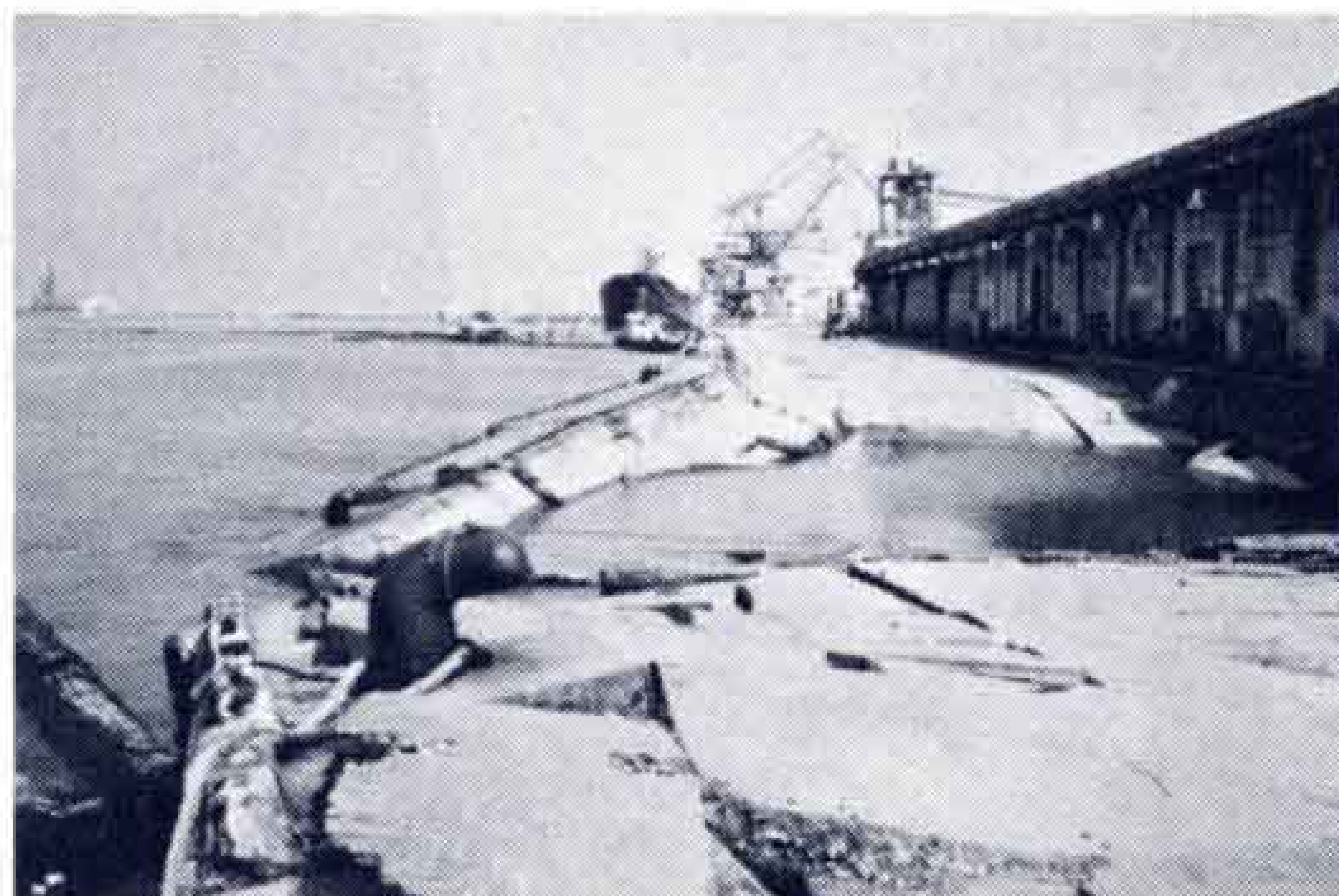
「日本海中部地震」の津波による被害
