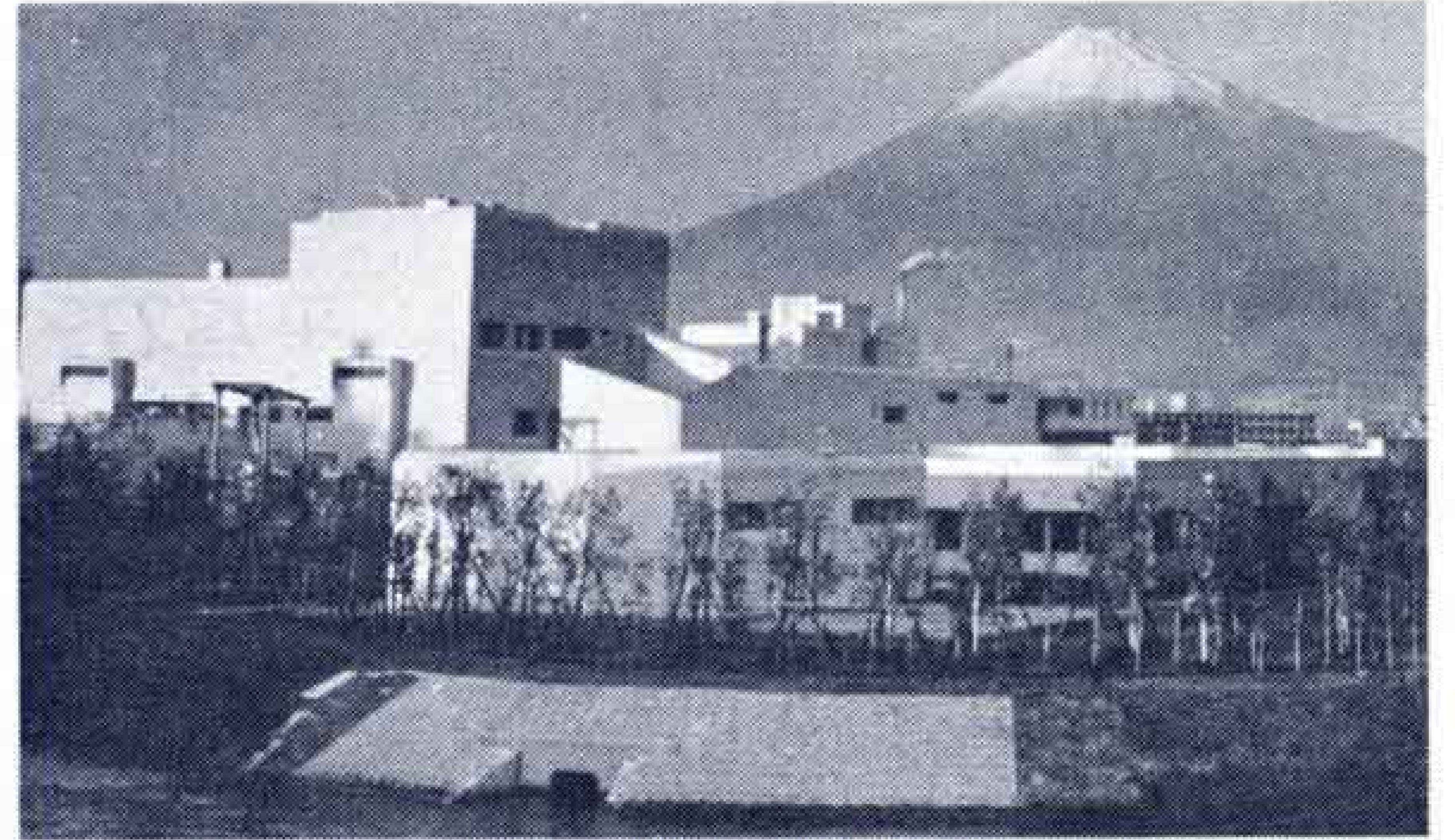
西部浄化センター
