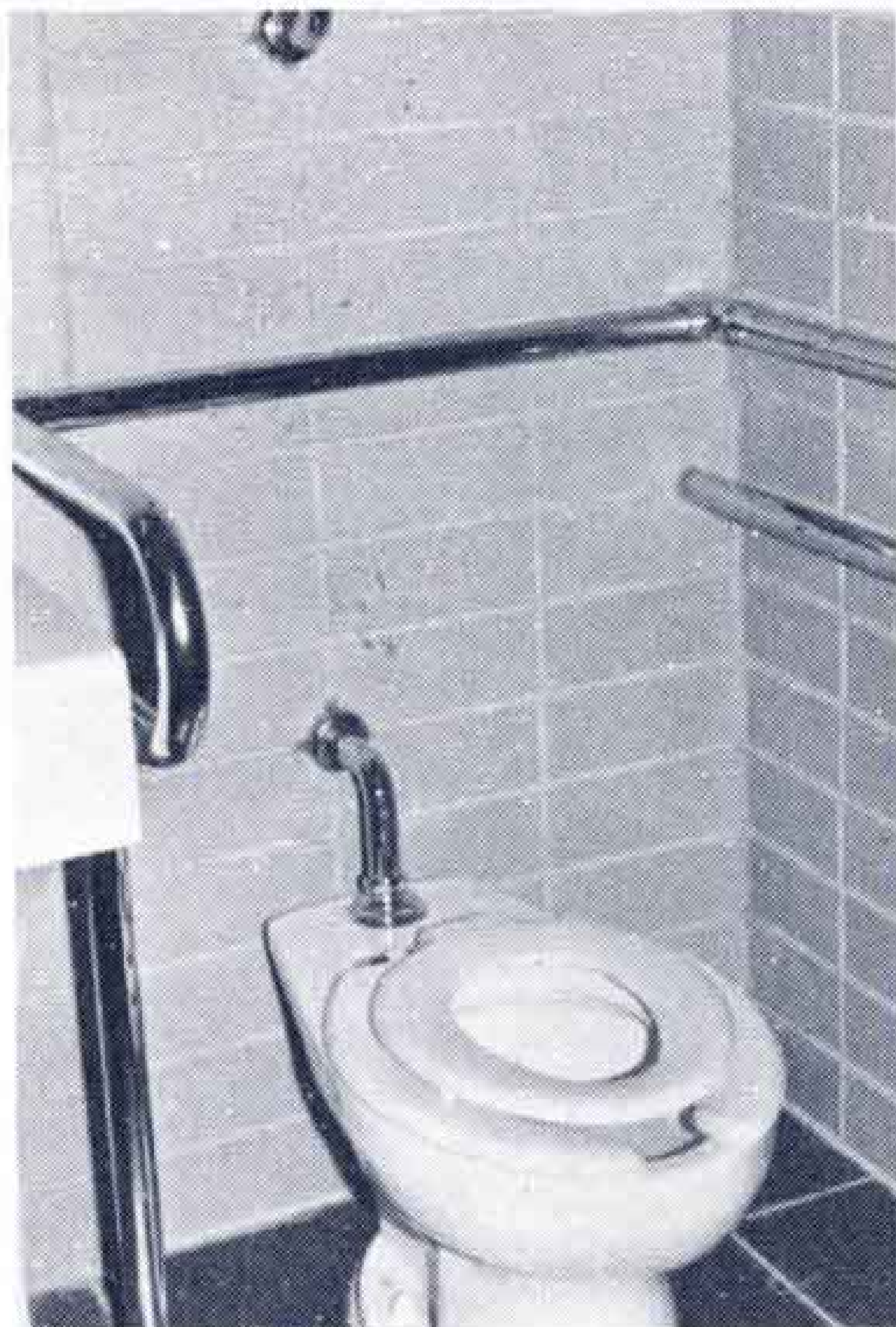
〔富士信用金庫本店障害者トイレ〕
