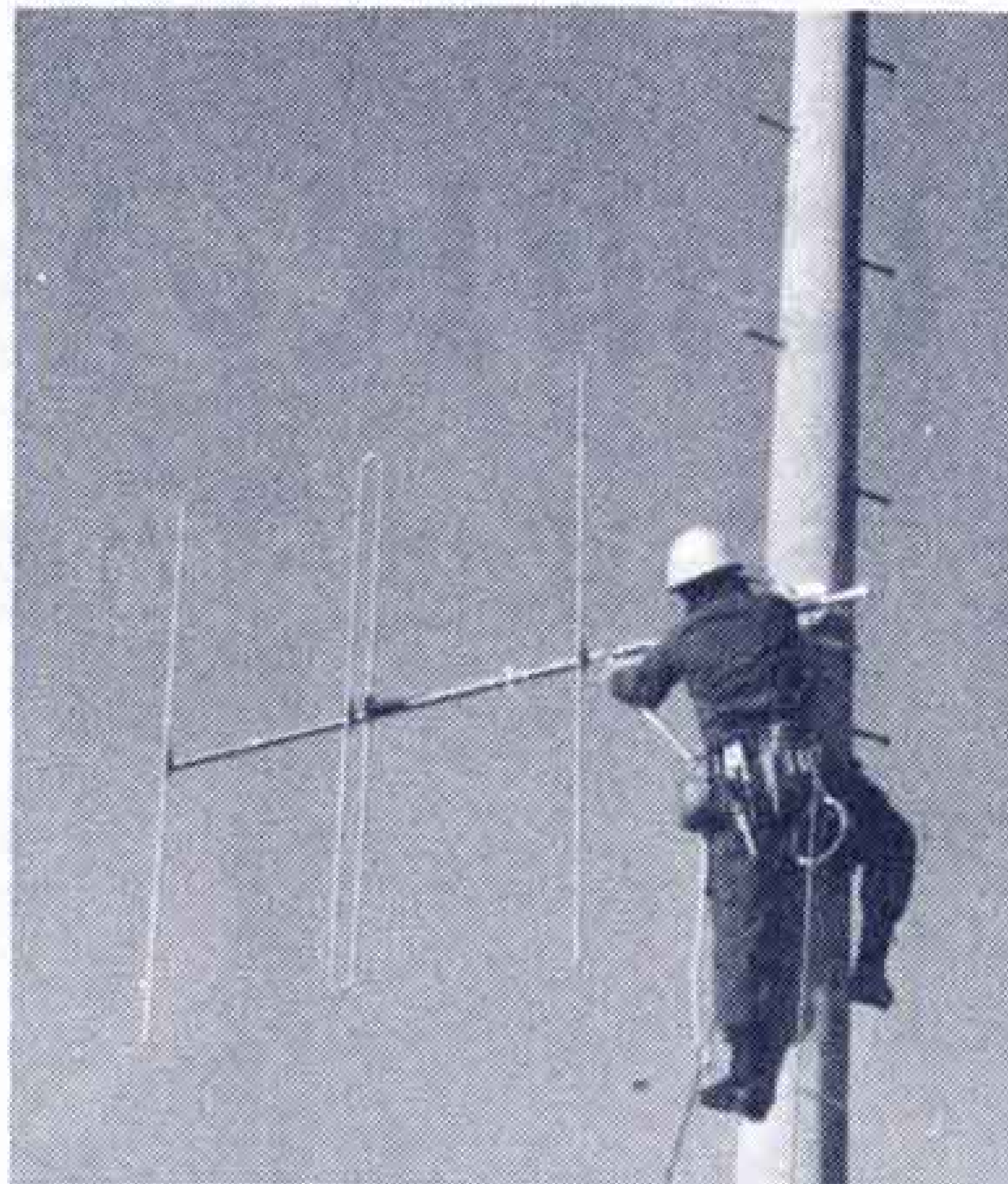
▲アンテナ取替え中の広報塔
