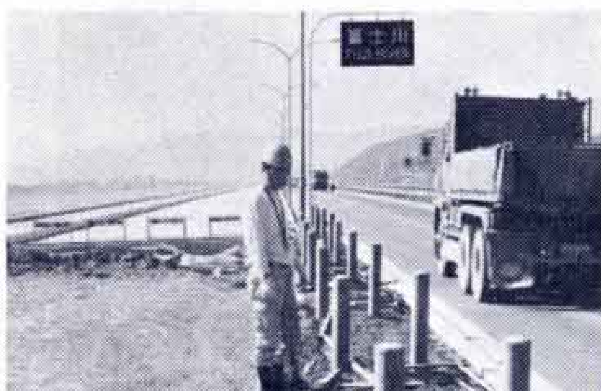
拡幅された新富士川橋
