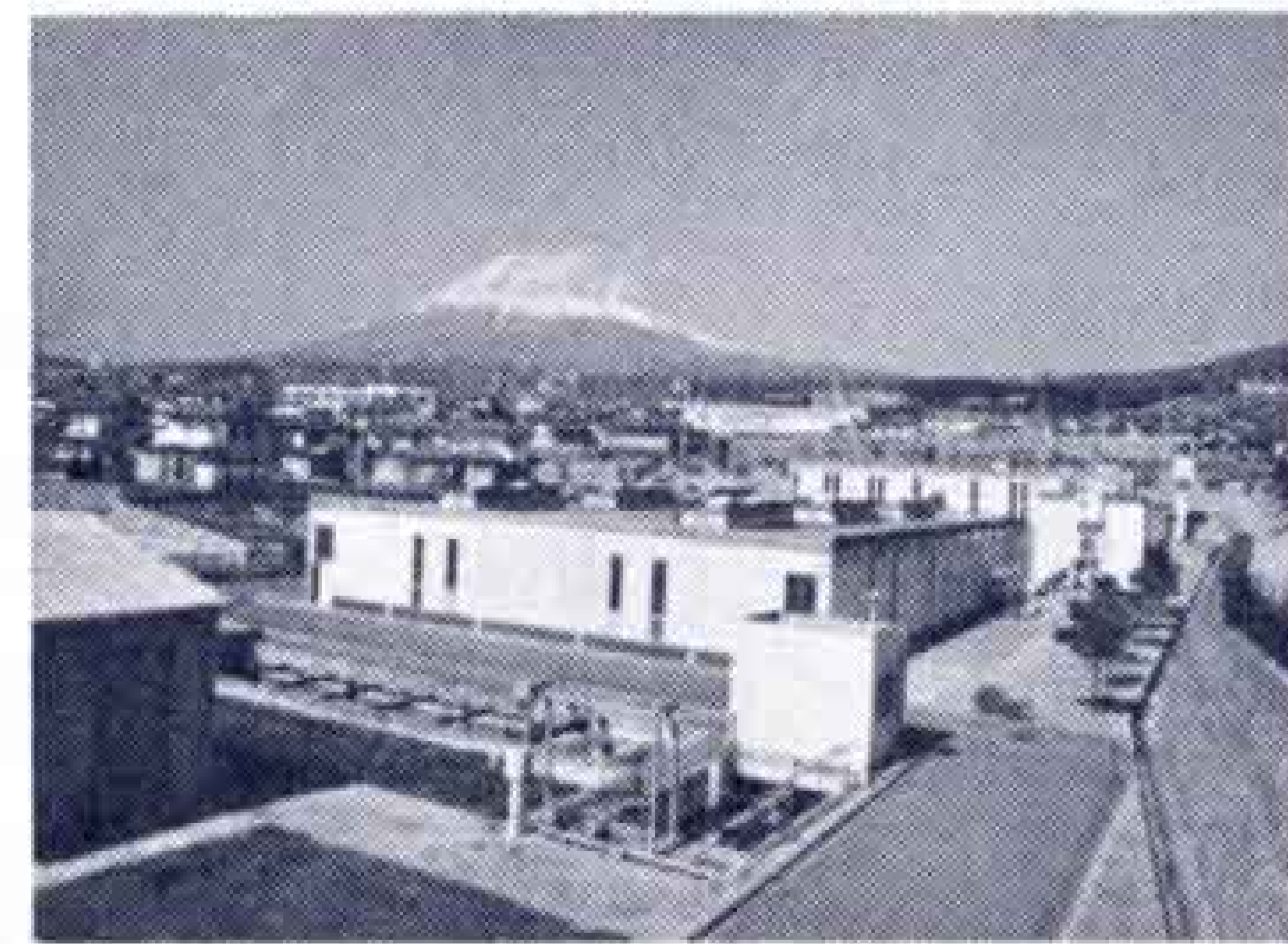
富士見台下水処理場
