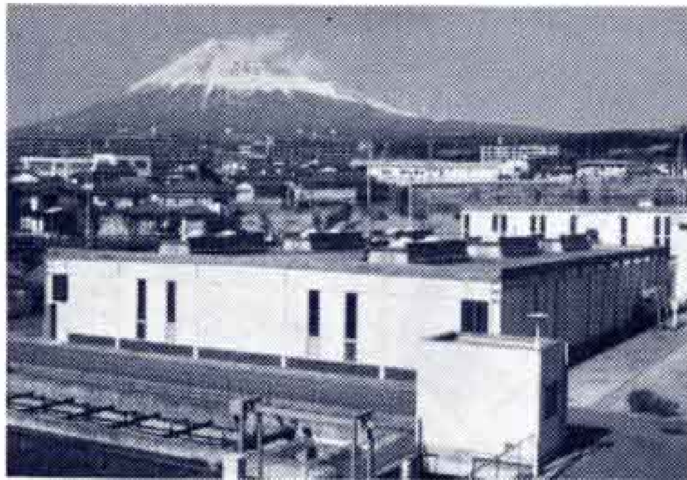
【富士見台下水処理場】
