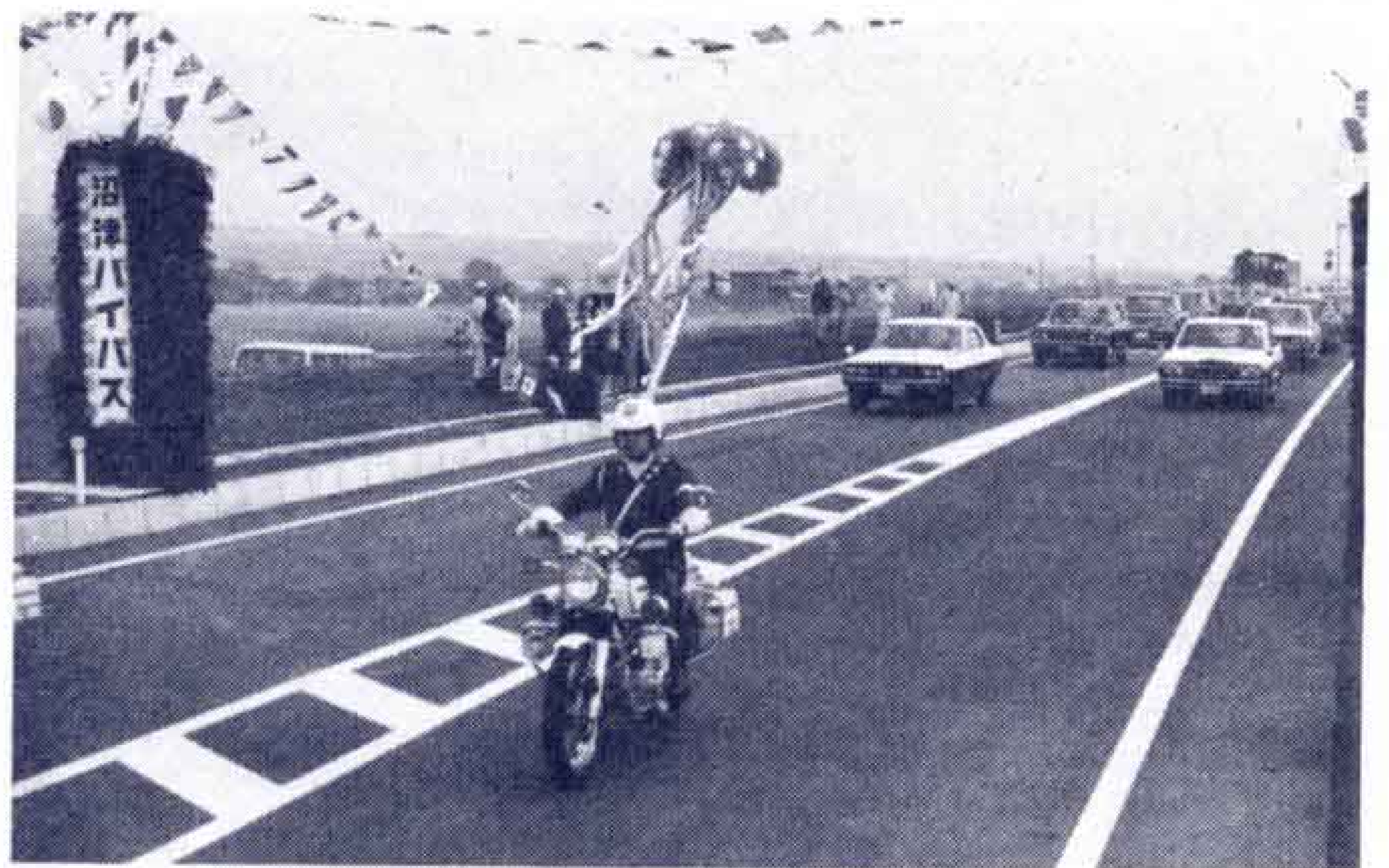
【写真・沼津バイパスの開通式】
