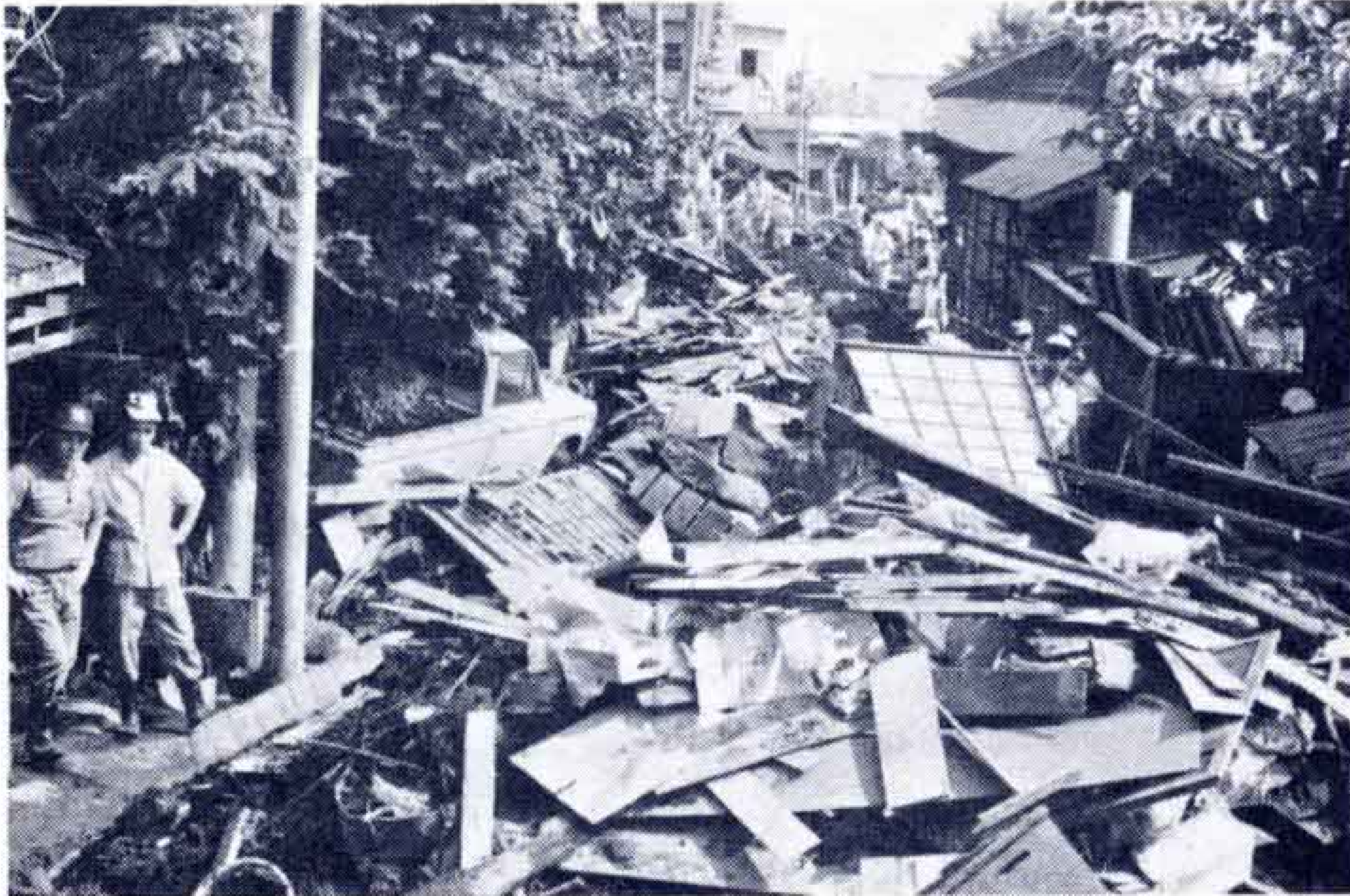
集中豪雨で被害を受けた富士岡地区 (51・8・9)
