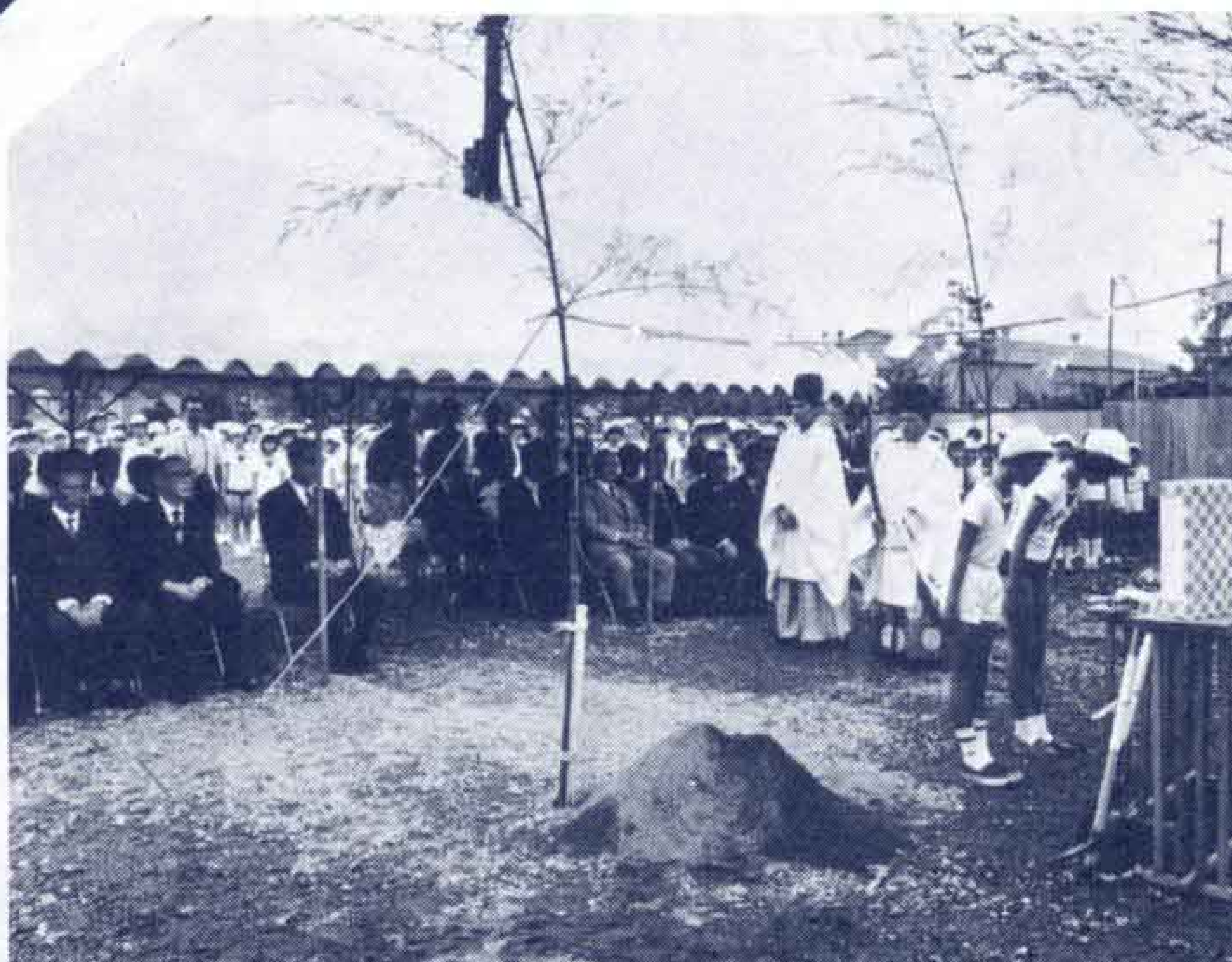
【7月11日に新校舎の起工式】
