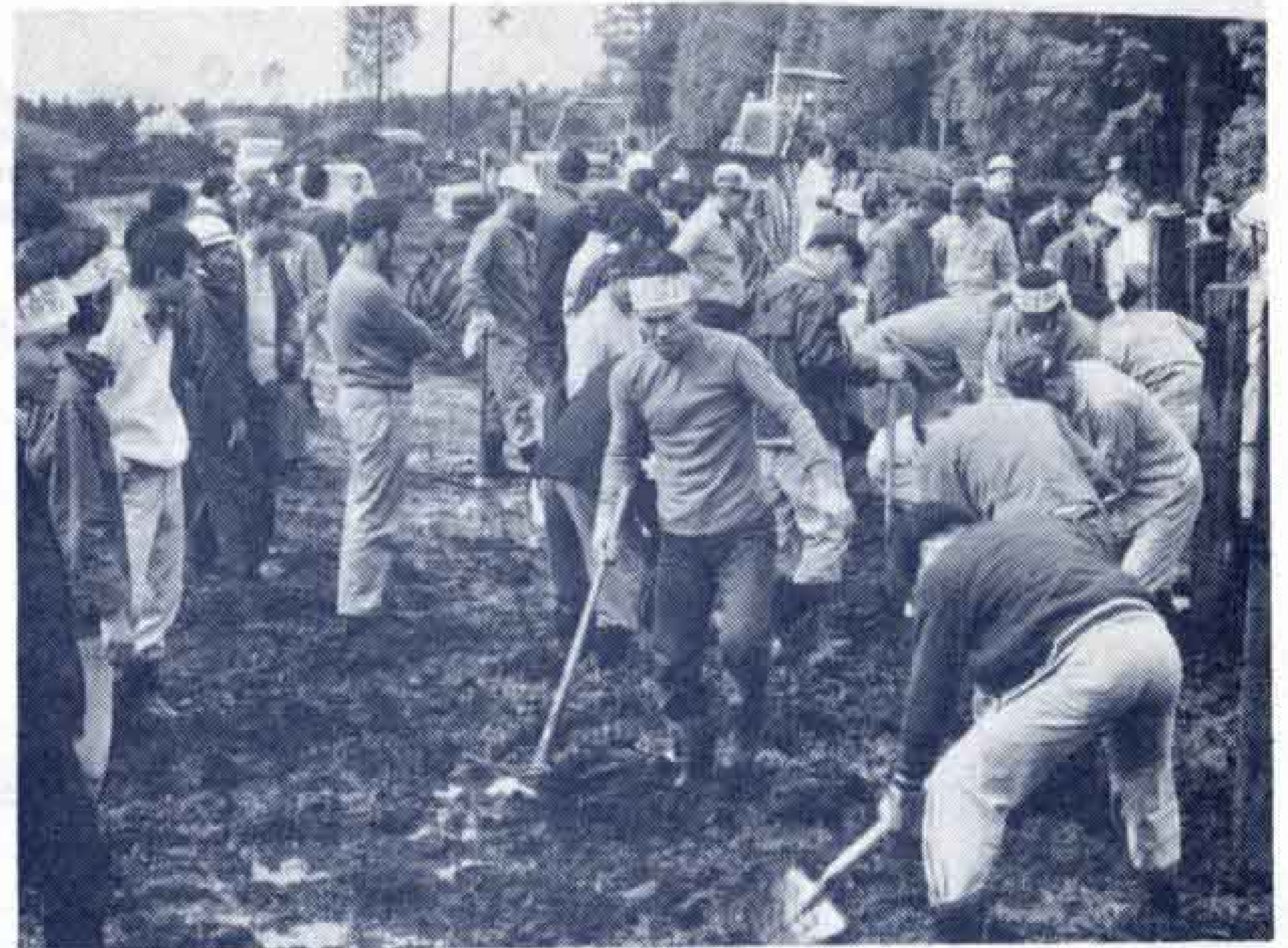
昨年10月27日、「ゴルフ場建設に乱開発を許すな」と市民団体も立ち上がり公道との境にクイ打ち
