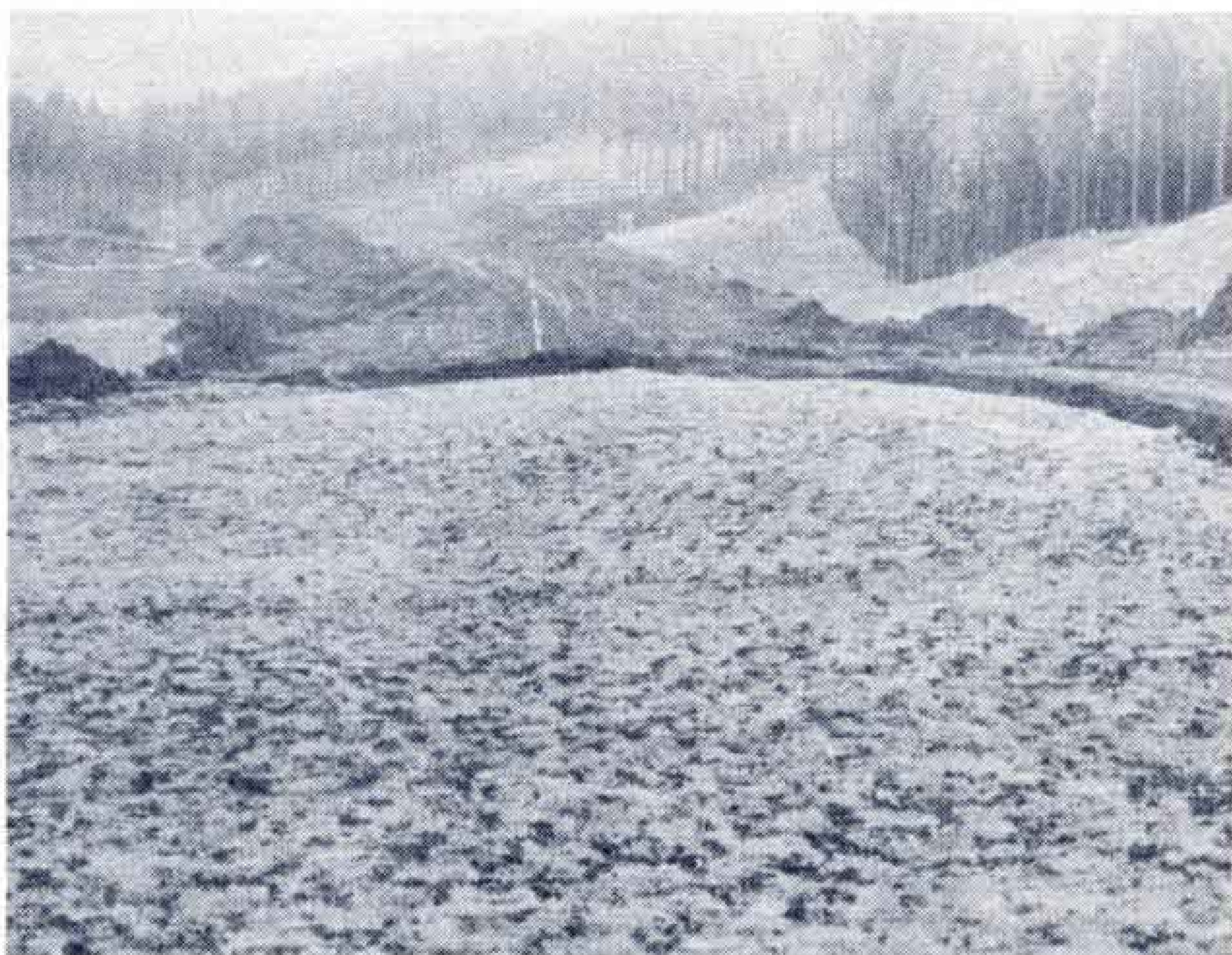
【一部では芝張りを始めています】
