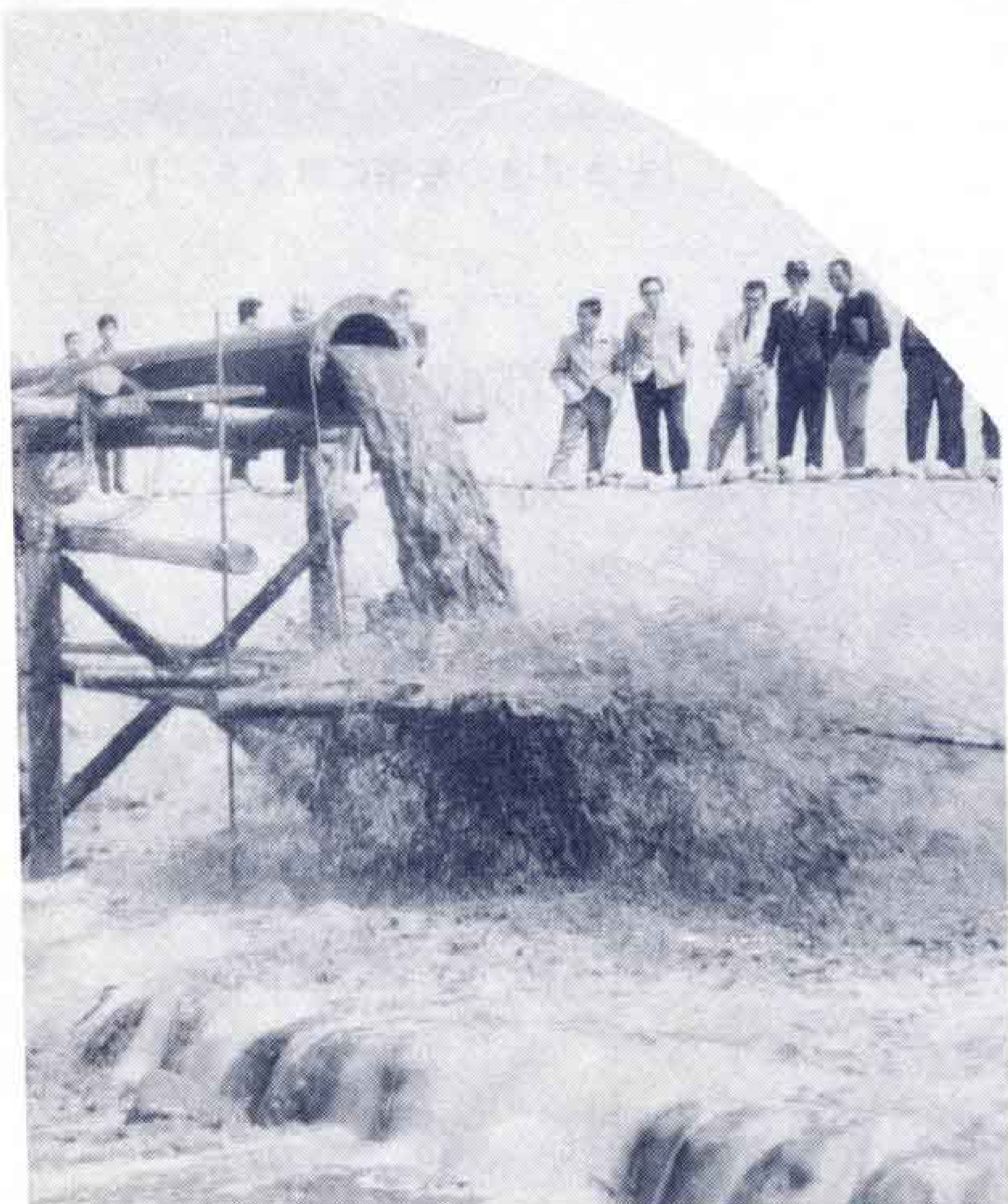
■河川敷へヘドロを送り脱水
