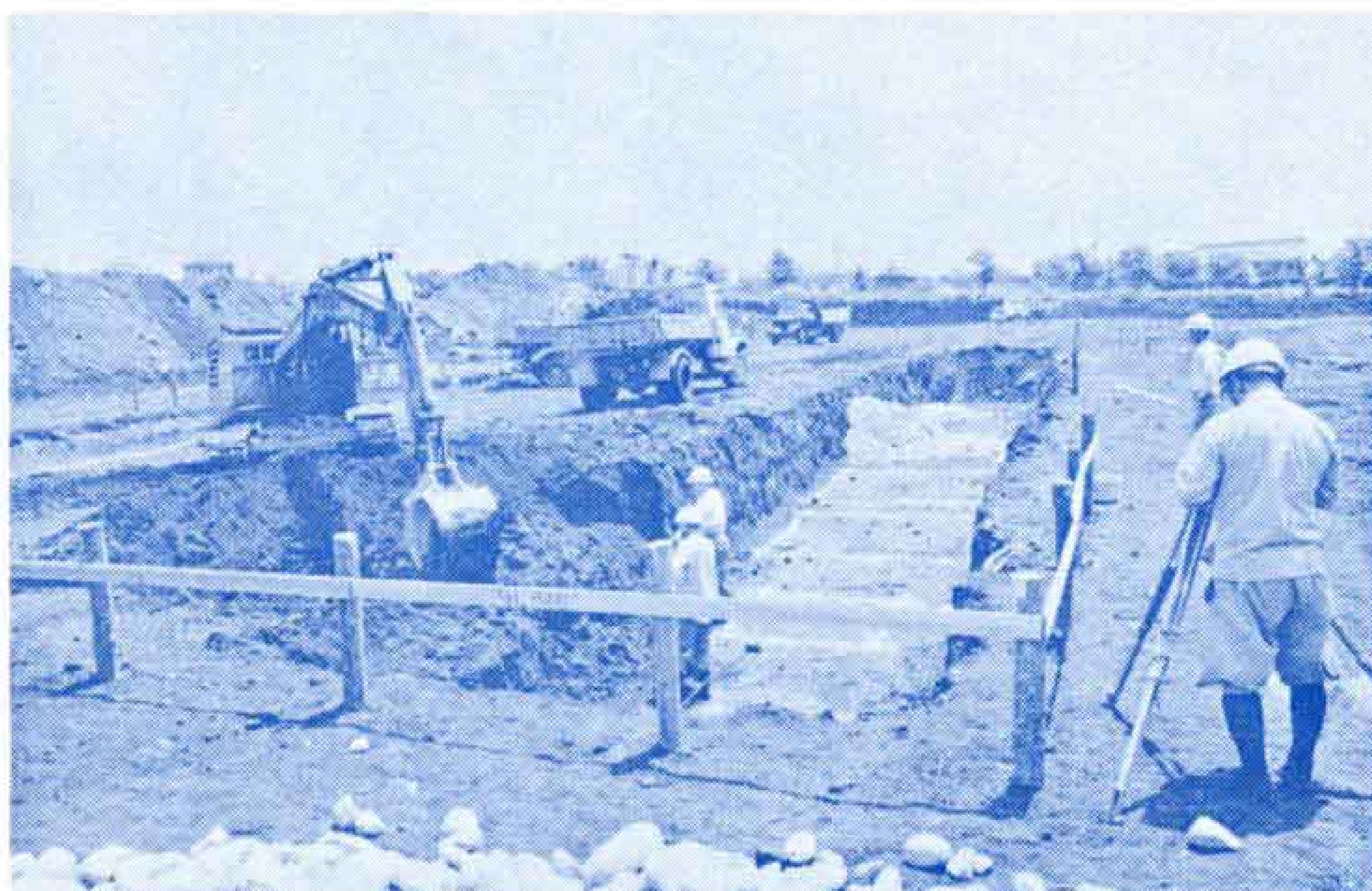
【建設をはじめた厚原小学校】
