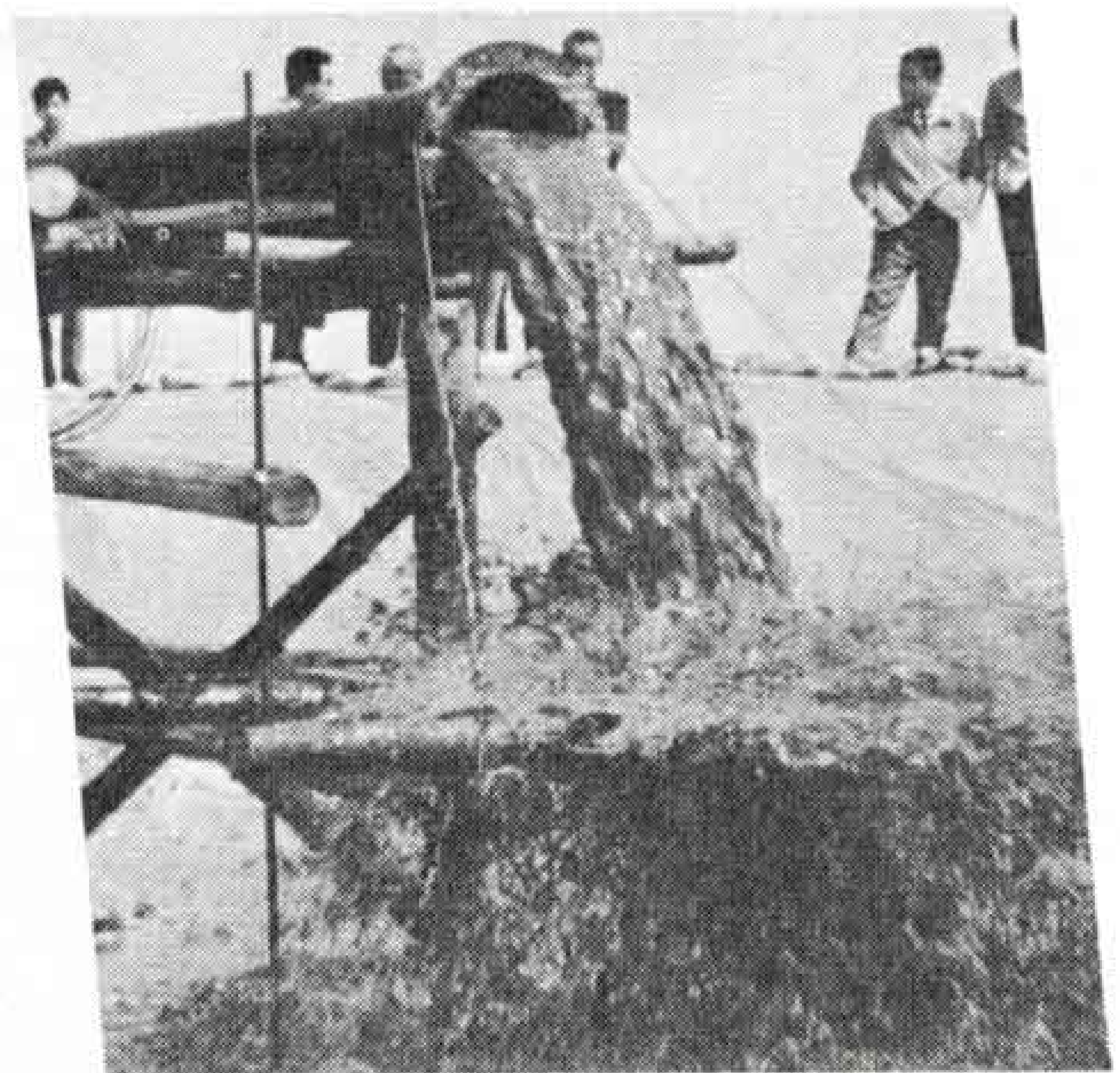
富士川河口敷8万平方mに、砂利を積みあげて処理場をつくりここでへドロを脱水
