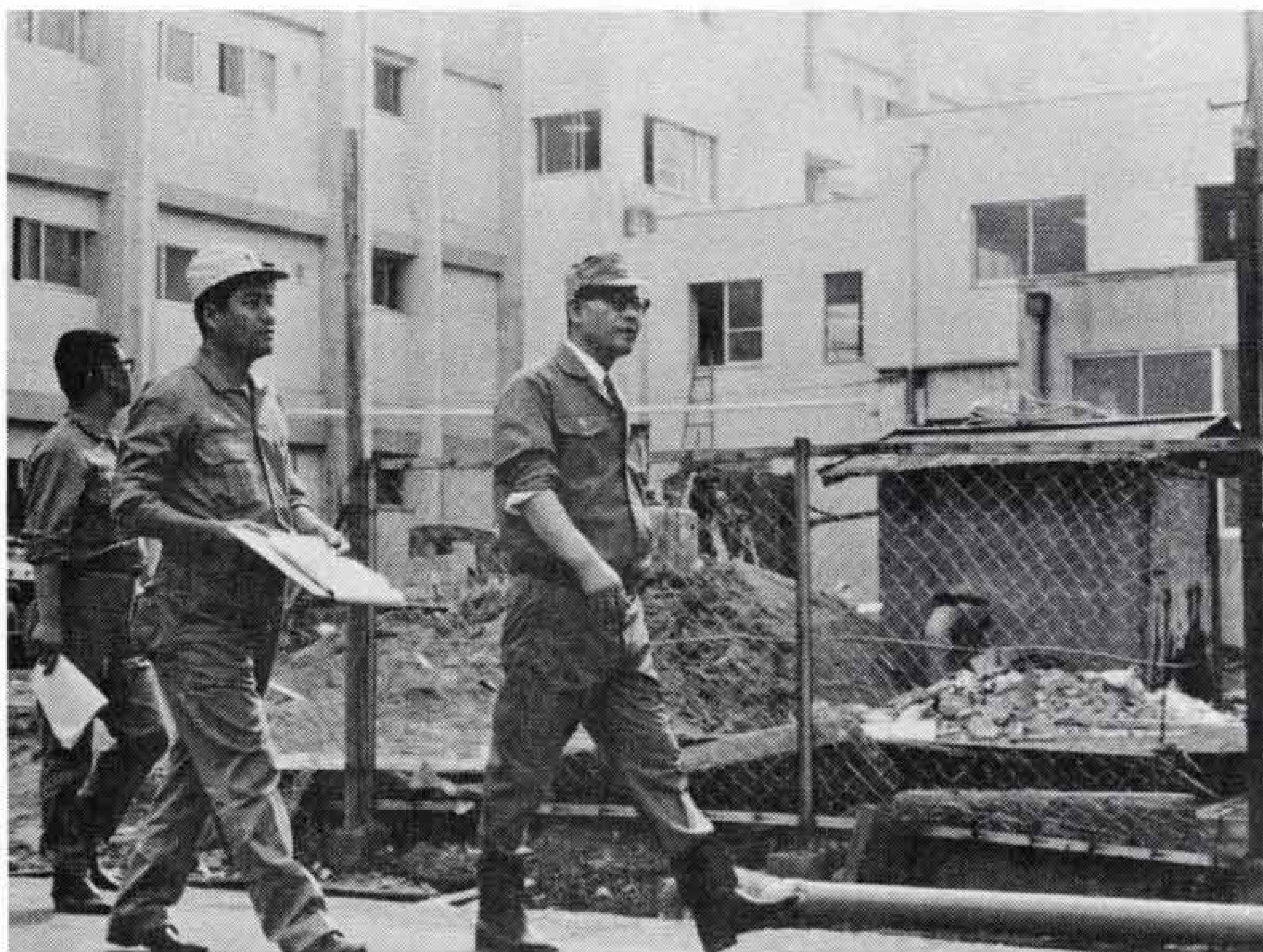
【市立中央病院の増築現場を視察する渡辺市長】
