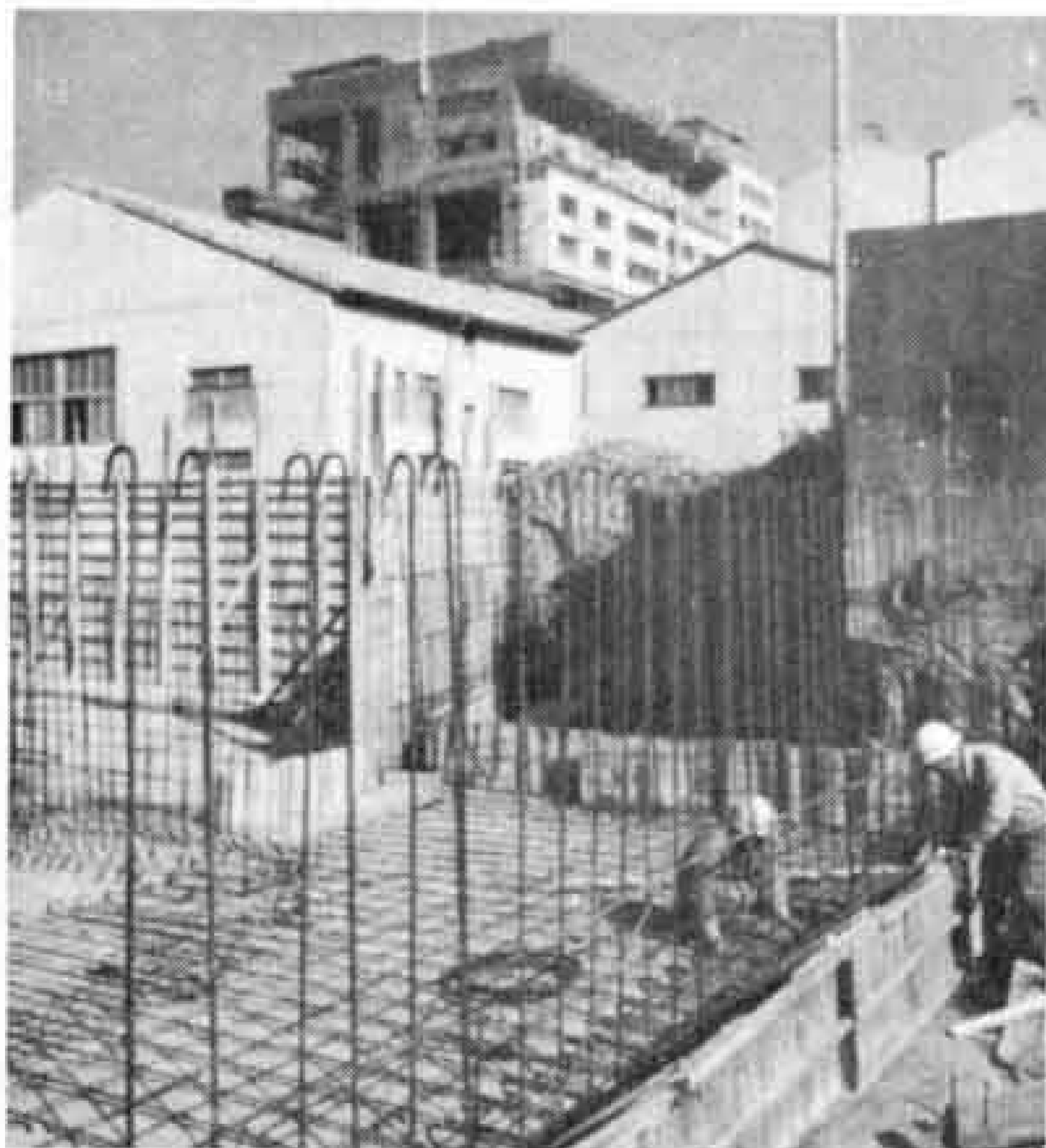
【工場から排出される水質を保つために 中和槽、沈澱槽などを拡充しています】
