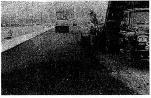
**進む舗装** タイヤローラー、大型ブルドーザー、スクレーパーなどの近代機械が使用され、下り線はインターチェンジから富士川橋までほとんど舗装されました。
