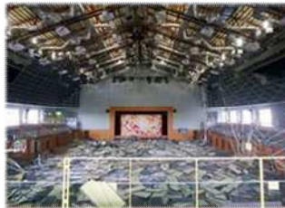
落下した吊り天井 （熊本地震：益城町）
