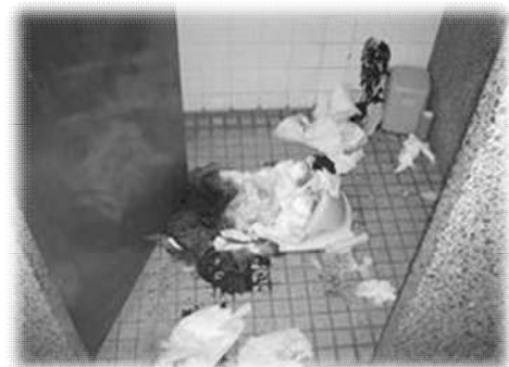
断水により汚れたトイレ
