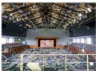
落下した吊り天井 （熊本地震：益城町）
