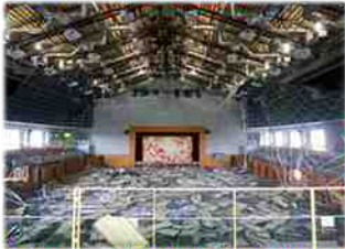
落下した吊り天井 (熊本地震：益城町)
